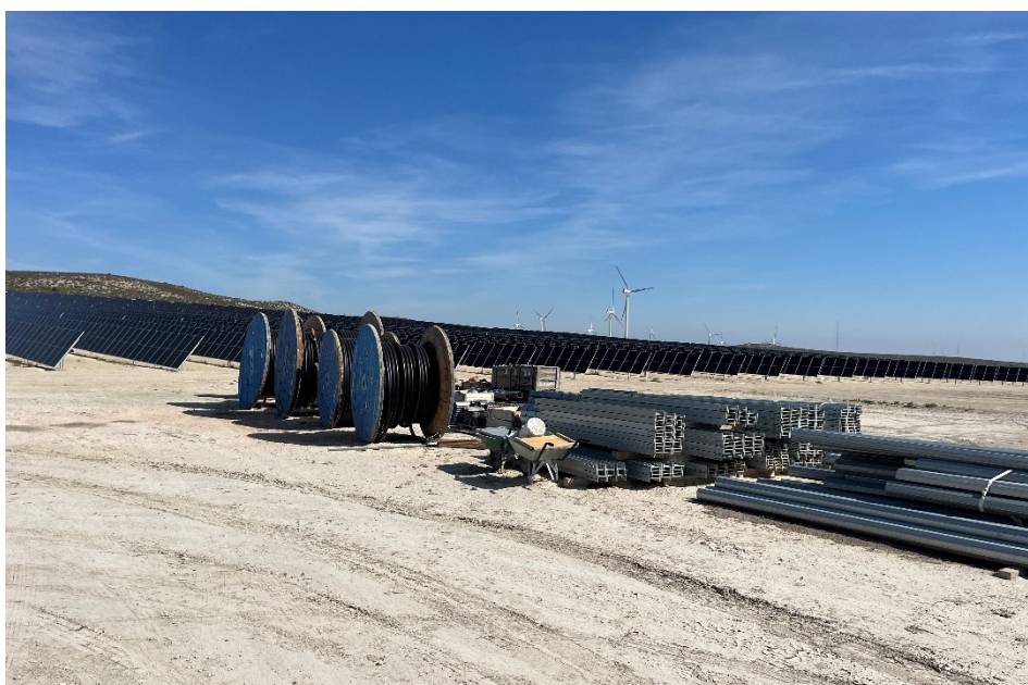
Figura 7 Acopio del material de construcción
