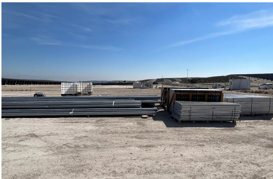
Figura 6 Acopio del material de construcción
