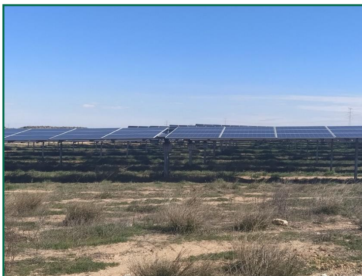
Fotografía 1. Vegetación entre placas actualmente.
