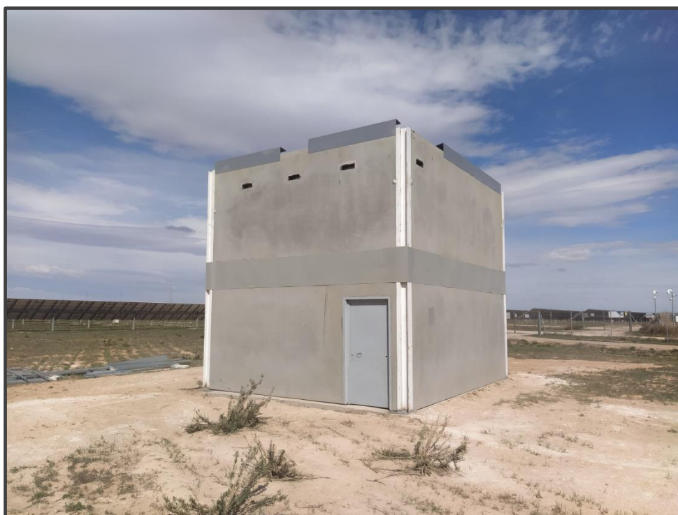
Fotografía 4. Exterior del primillar de nueva construcción.
