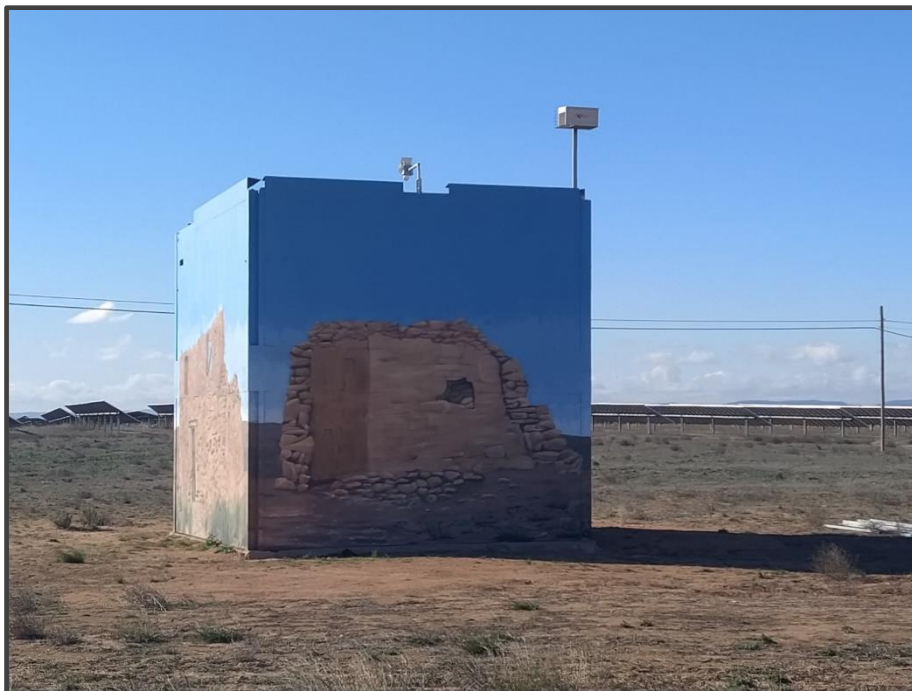
Fotografía 6. Exterior del primillar, pintado.
