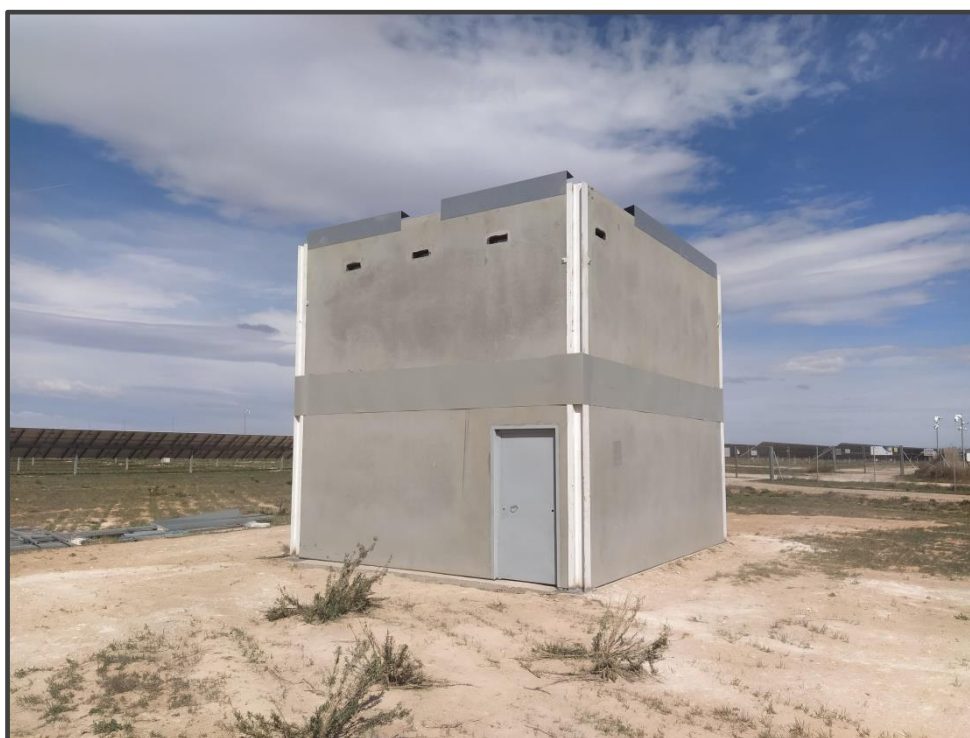
Fotografía 4. Exterior del primillar de nueva construcción.
