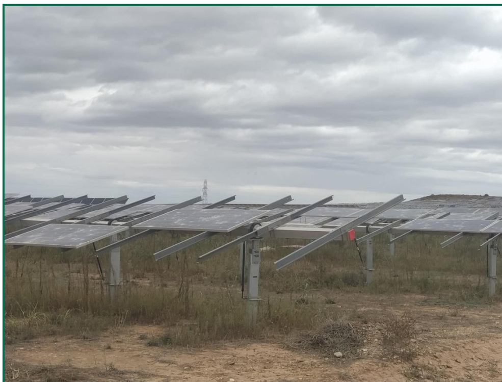
Fotografía 1. Vegetación entre placas actualmente.
