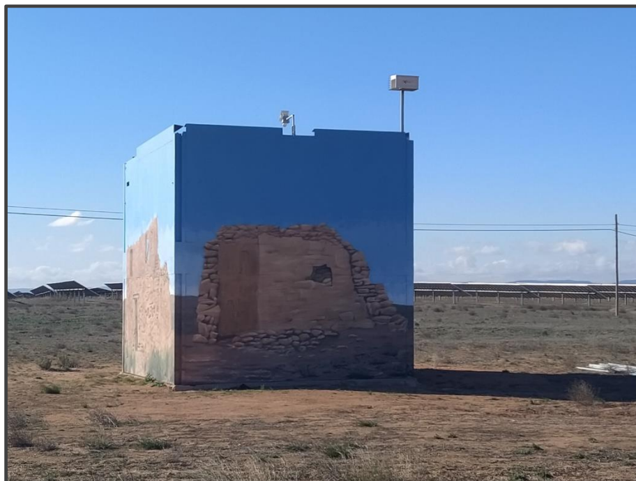
Fotografía 6. Exterior del primillar, pintado.
