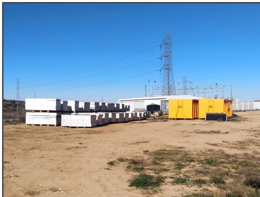
Fotografía 15. Zona de acopio de placas solares deterioradas.
