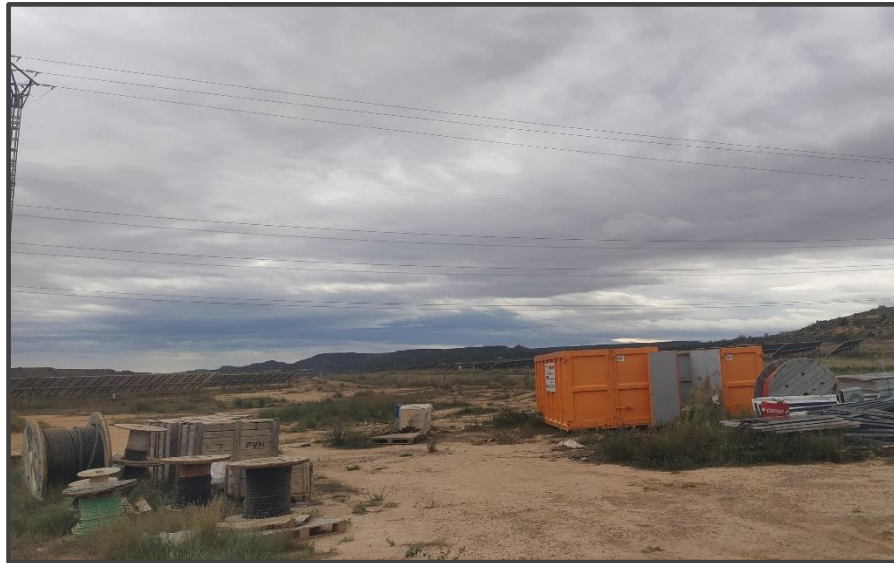
Fotografía 13. Contenedores de residuos.
