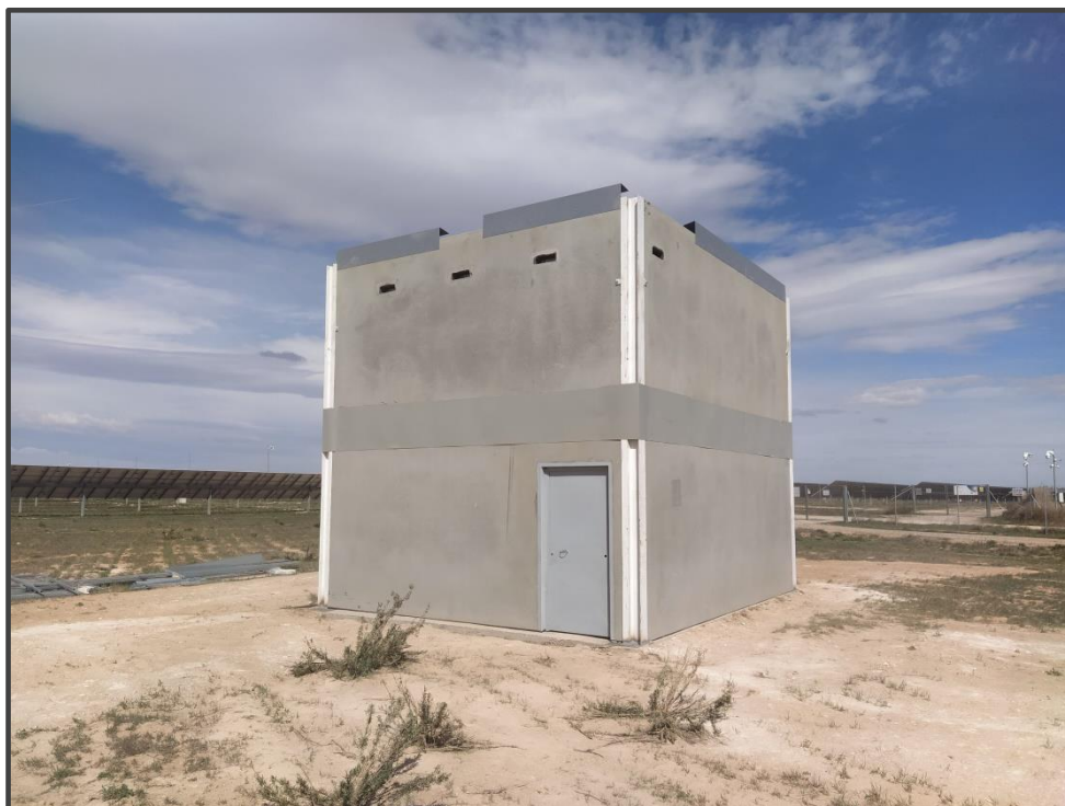
Fotografía 11. Exterior del primillar de nueva construcción.
