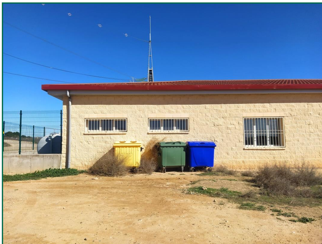
Fotografía 21. Contenedores de residuos no peligrosos en exterior de la subestación.
