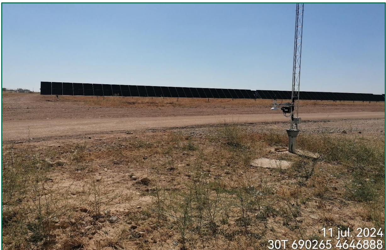
Fotografía 4. Vegetación en la planta solar.
