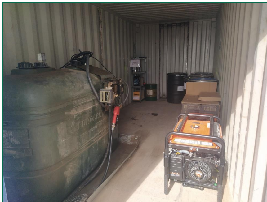
Fotografía 12. Zona de residuos peligrosos.
