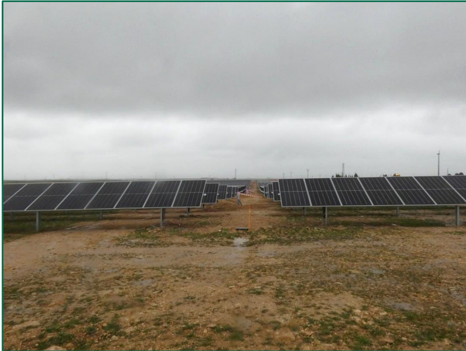
Fotografía 6. Superficie de la planta.
