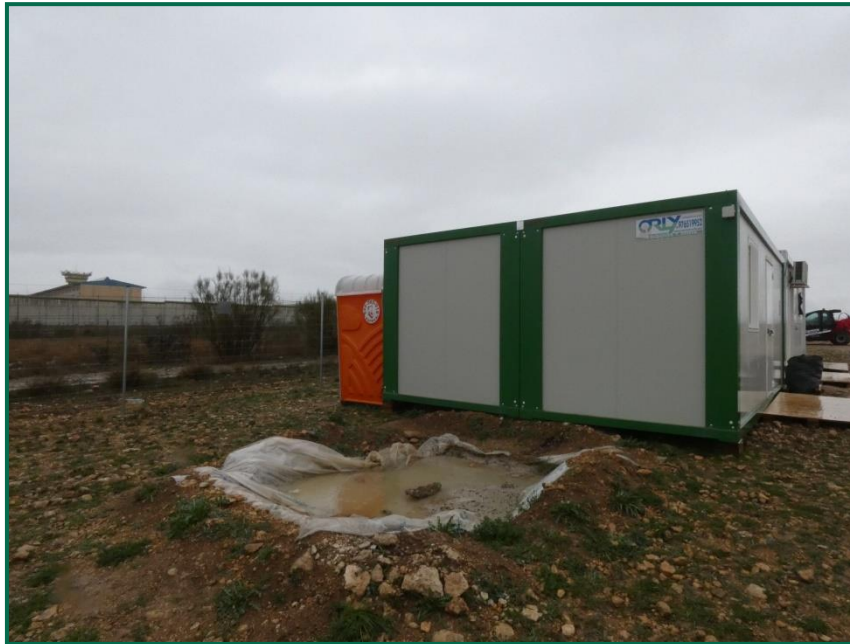
Fotografía 16. Zona para el lavado de canaletas.
