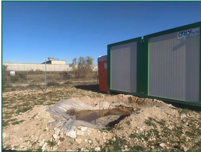
Fotografía 16. Zona para el lavado de canaletas.
