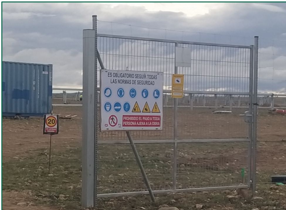
Fotografía 4. Señal de limitación de velocidad.
