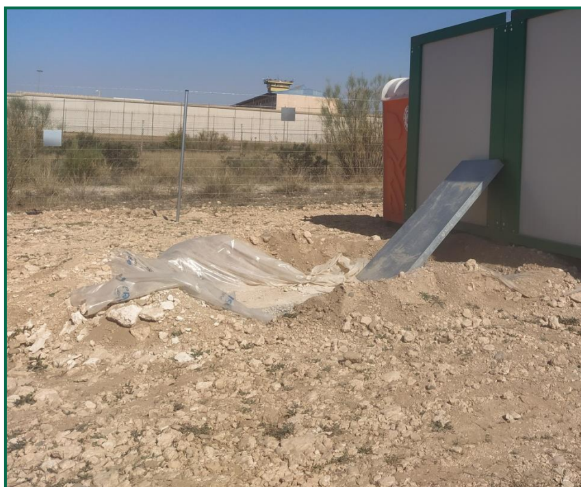
Fotografía 11. Zona para el lavado de canaletas.
