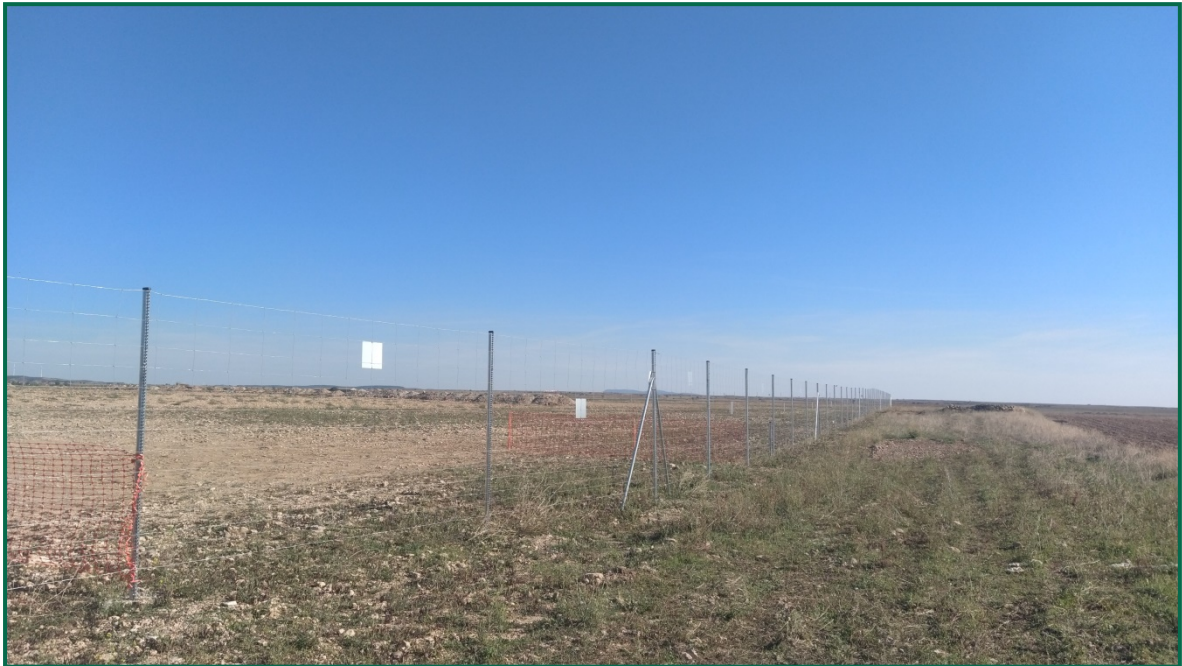
Fotografía 5. Vallado perimetral con pasos de fauna.
