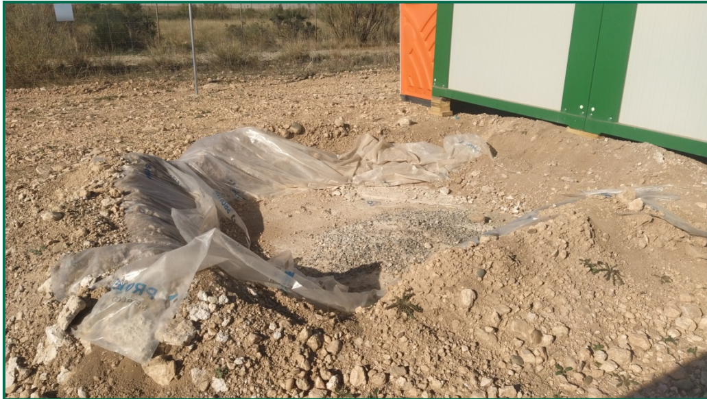
Fotografía 6. Zona para el lavado de canaletas.
