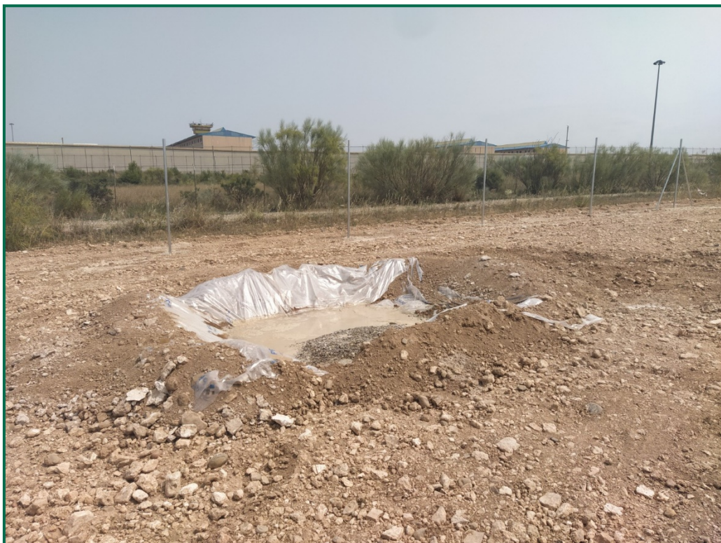
Fotografía 5. Zona para el lavado de canaletas.
