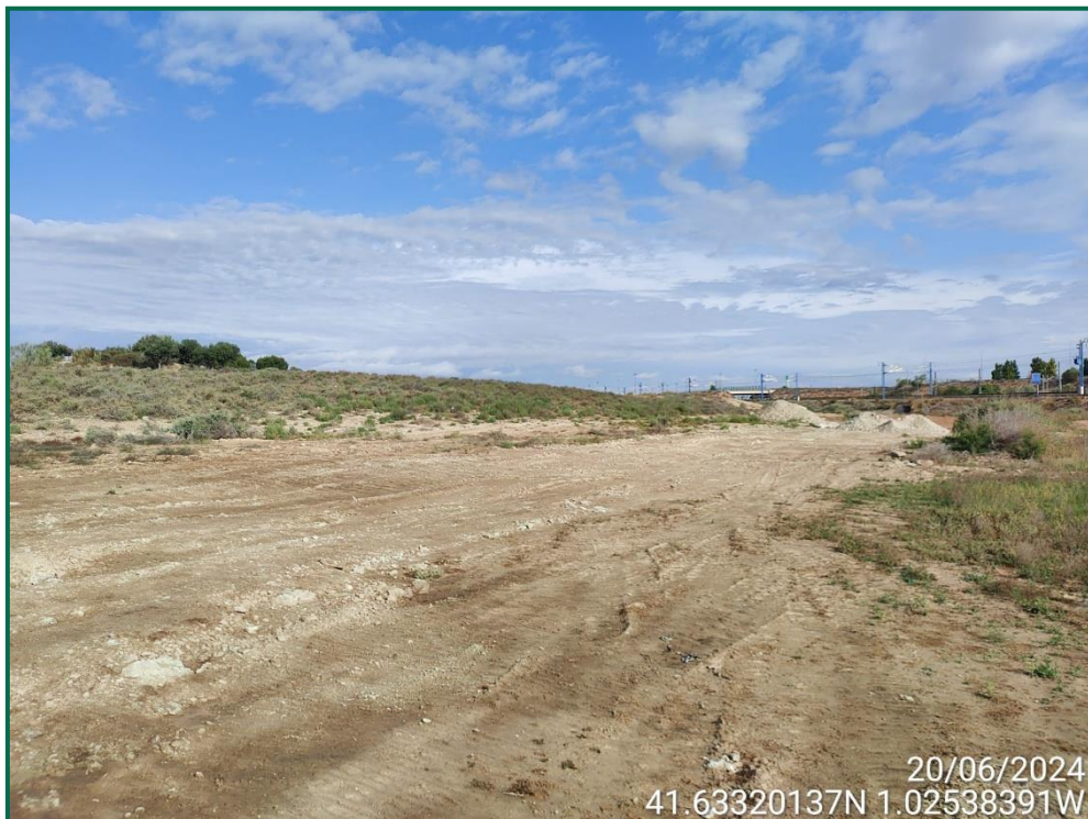
Fotografía 30. Tapado de zanjas.
