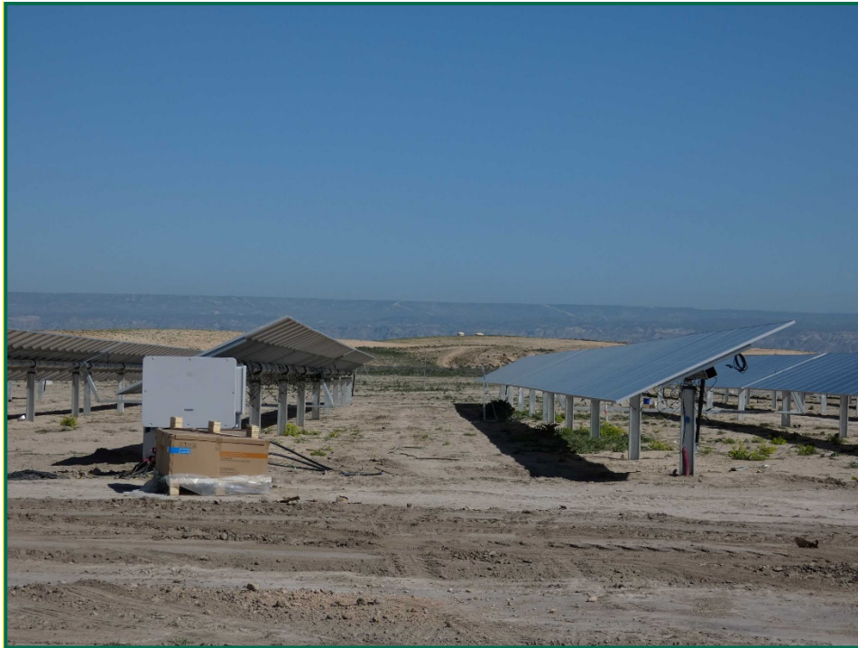
Fotografía 4. Colocación de las placas fotovoltaicas.
