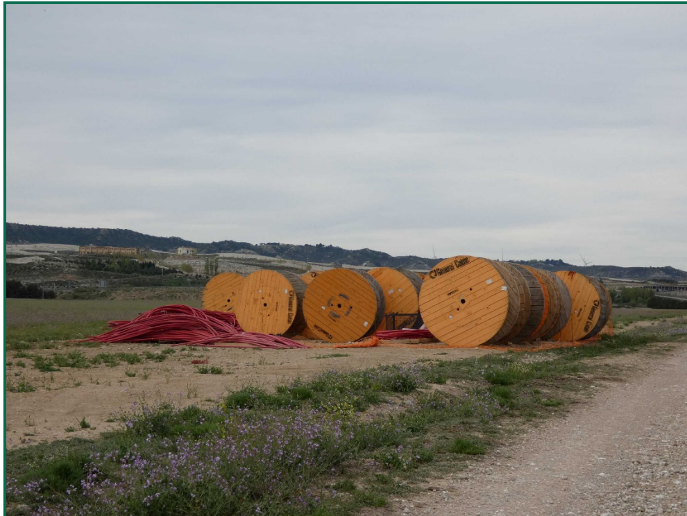
Fotografía 35. Bobinas de cable utilizadas.
