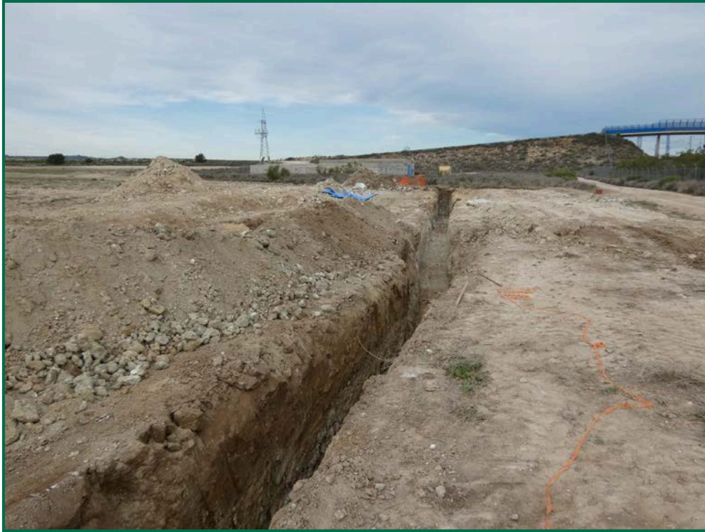
Fotografía 33. Realización de zanjas y acopios de tierra.
