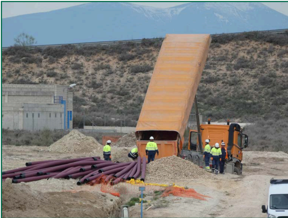
Fotografía 34. Maquinaria y personal trabajando en la línea de evacuación.
