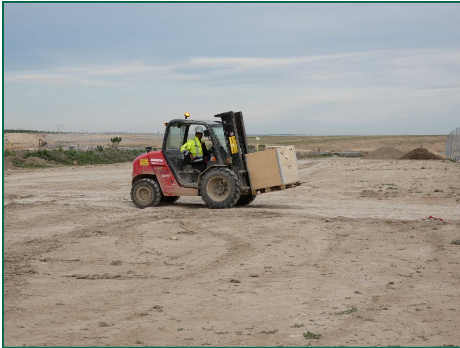
Fotografía 3. Maquinaria de obra.
