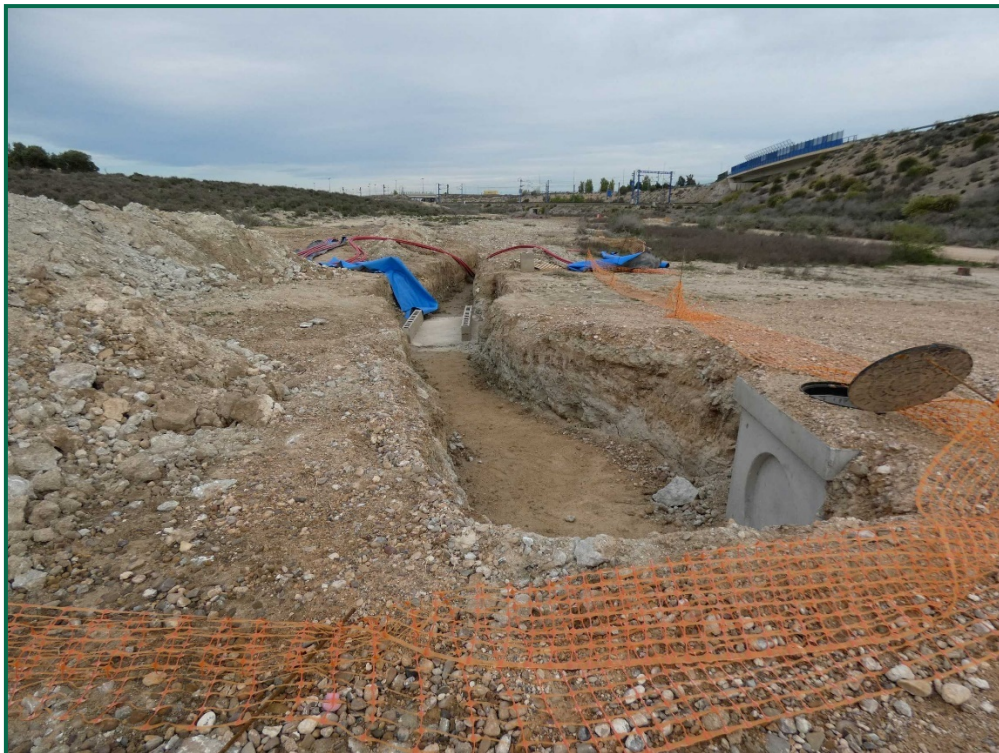
Fotografía 32. Balizamiento de la zanja.
