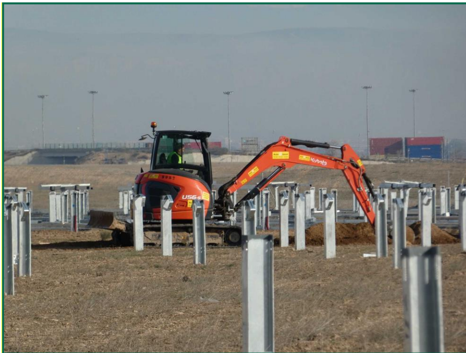
Fotografía 5. Excavadora realizando zanjas.
