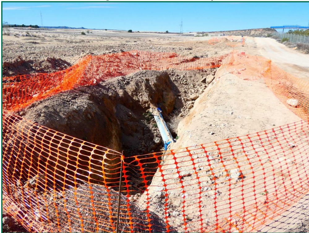
Fotografía 26. Descubrimiento de gasoducto y balizado de zanja.
