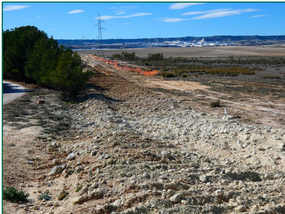
Fotografía 30. Tapado de zanjas.
