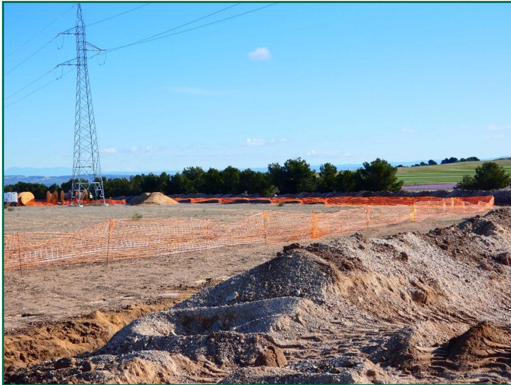
Fotografía 25. Balizamiento de la zanja.
