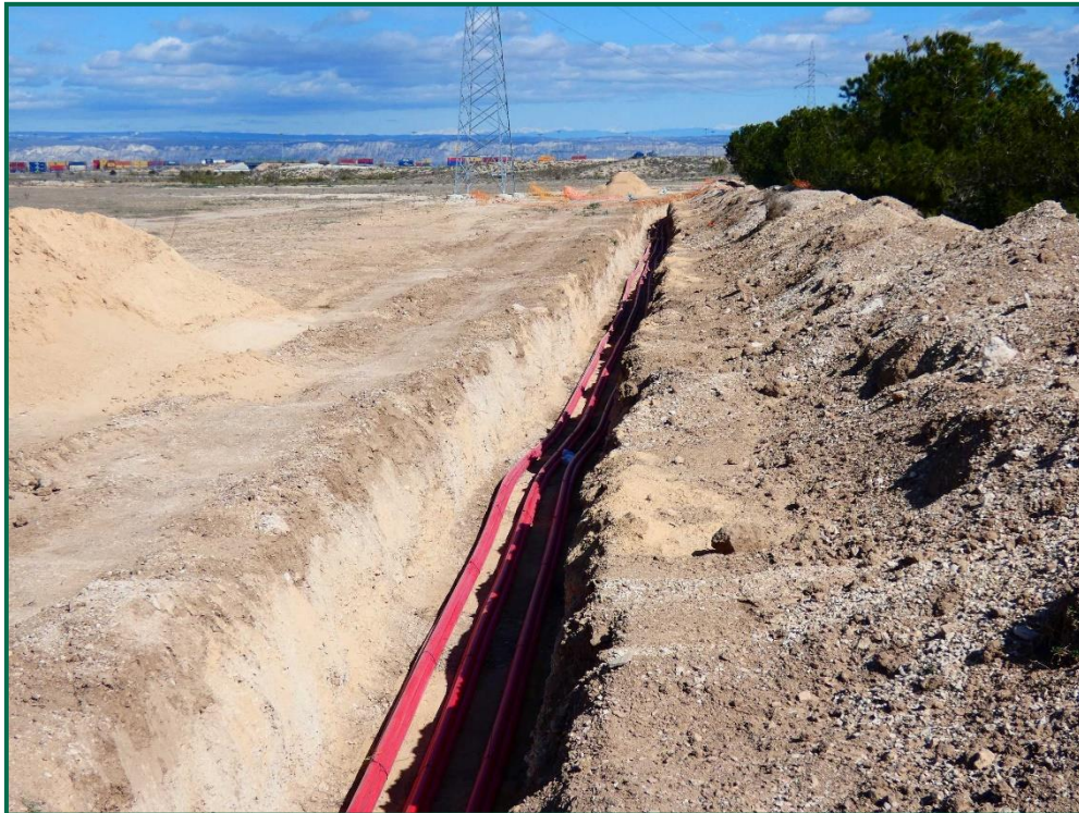
Fotografía 29. Colocación de cableado.
