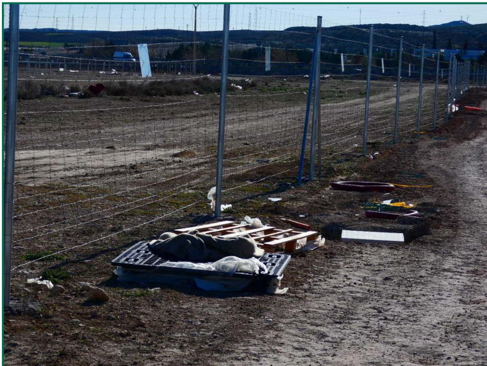
Fotografía 23. Restos de materiales en el interior de la planta.
