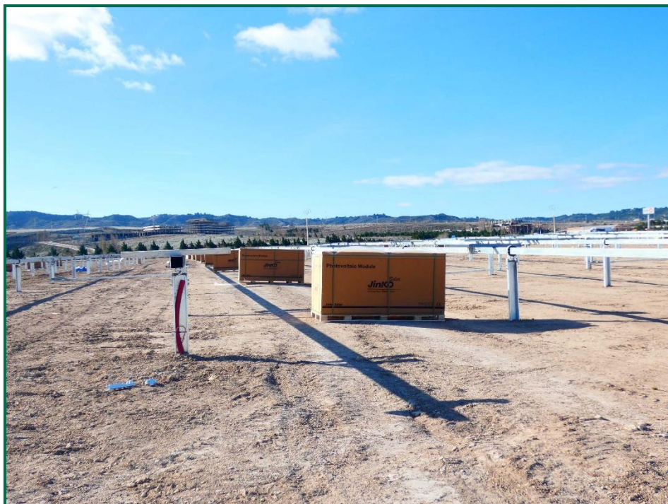
Fotografía 7. Preparación de las placas fotovoltaicas.
