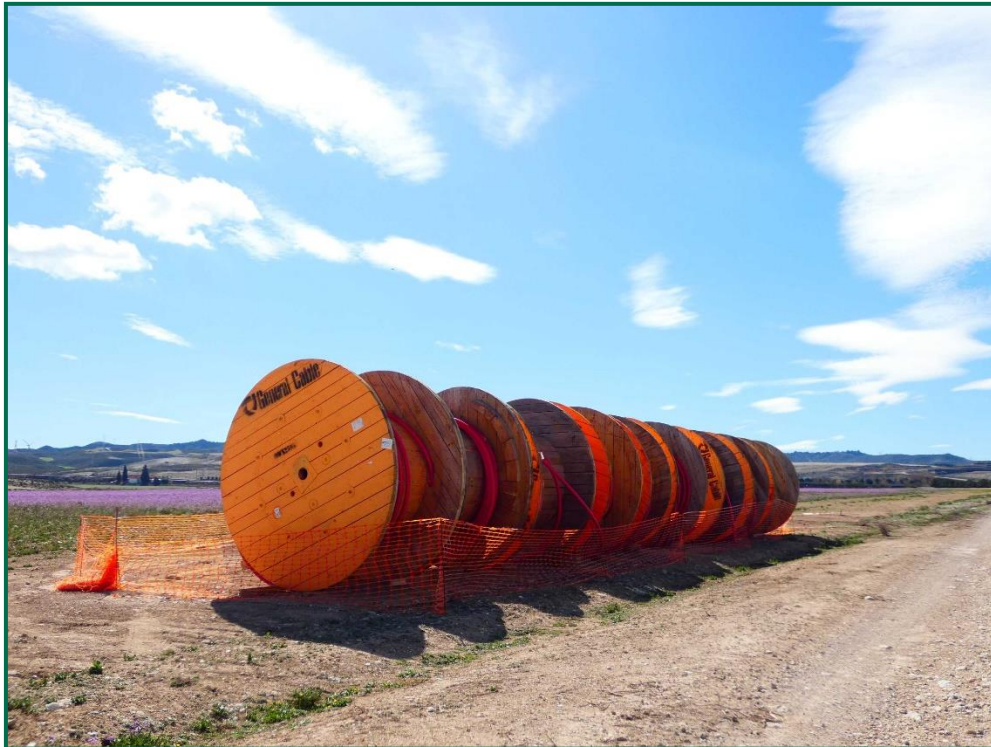
Fotografía 27. Balizado de las bobinas del cableado.
