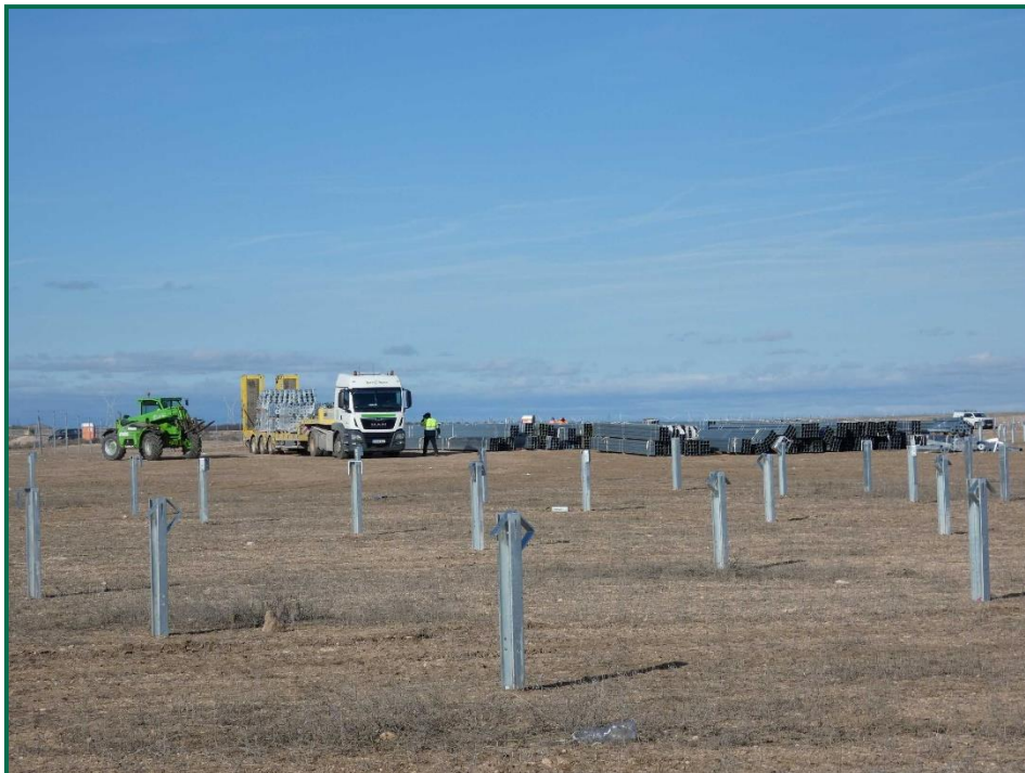
Fotografía 4. Recepción de materiales.
