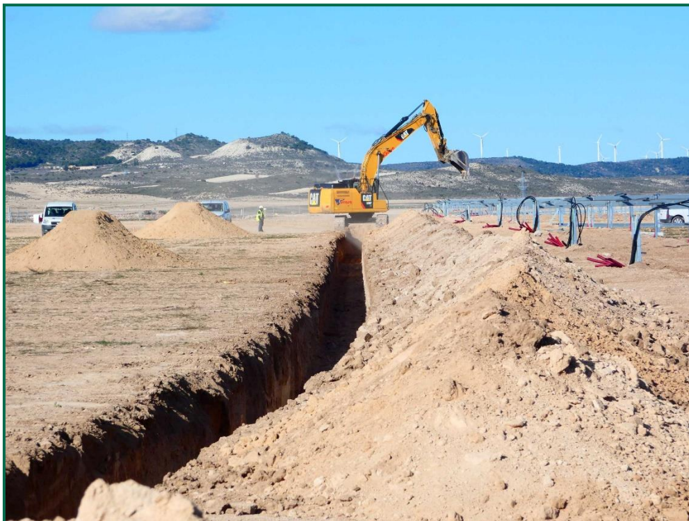
Fotografía 28. Realización de zanjas y acopios de tierra.
