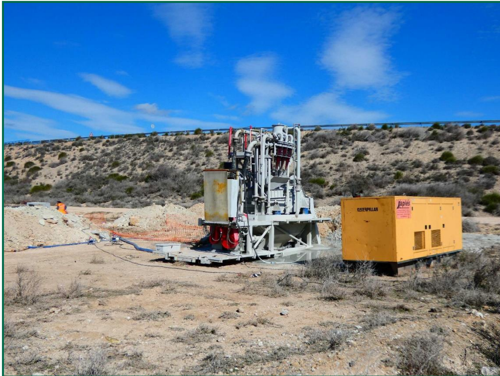
Fotografía 31. Final de la línea de evacuación.
