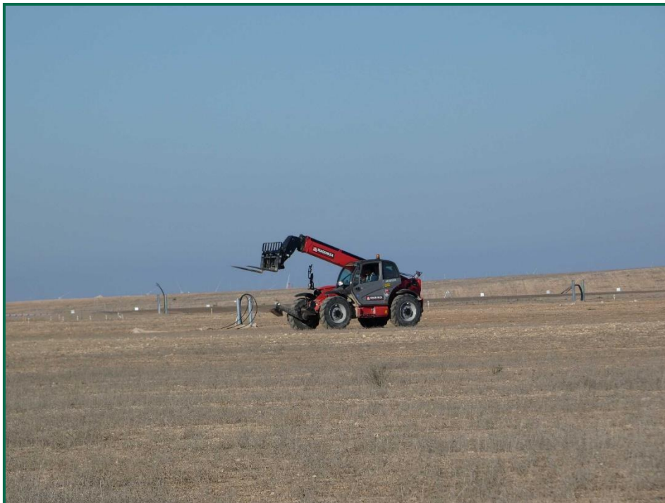
Fotografía 2. Maquinaria de construcción.
