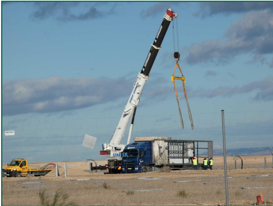
Fotografía 6. Colocación de la caseta del inversor.
