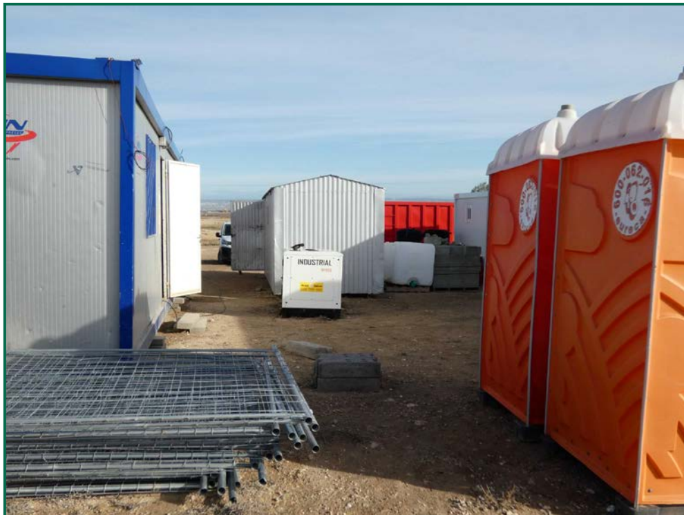
Fotografía 8. Vestuarios, servicios y materiales de obra.
