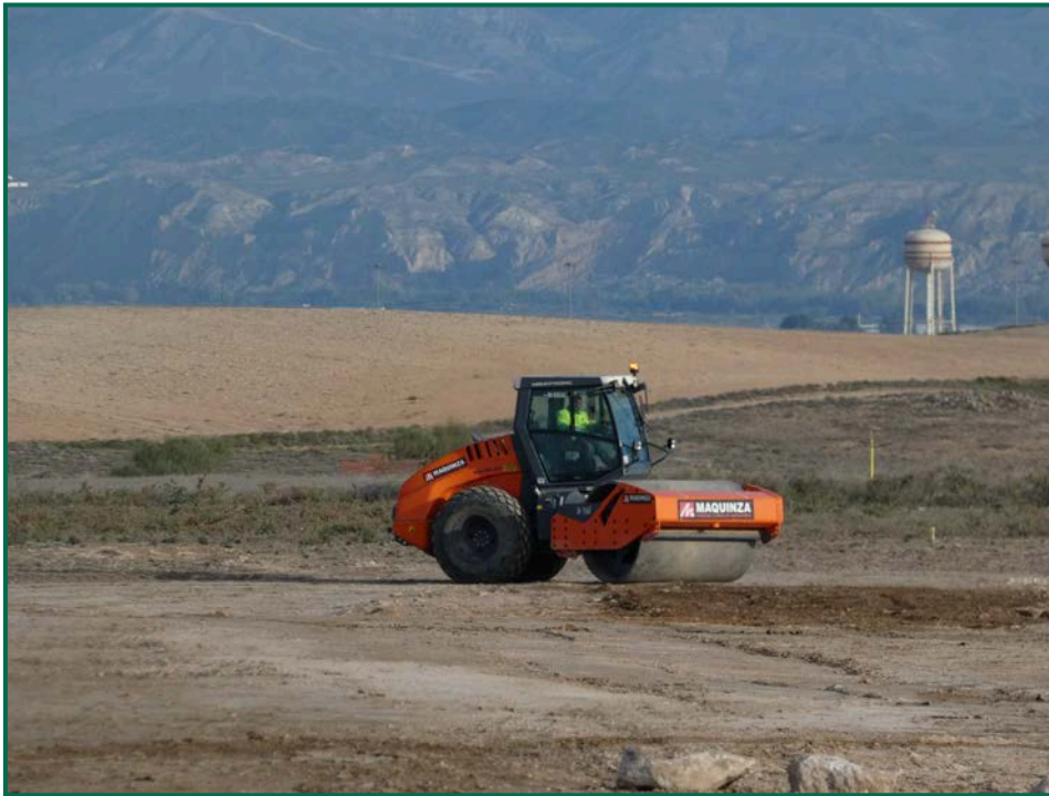
Fotografía 5. Rulo para aplanar el suelo.
