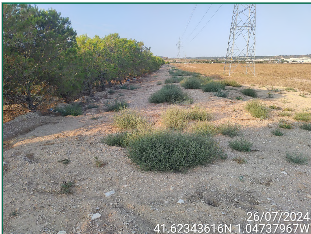
Fotografía 22. Tapado de zanjas.
