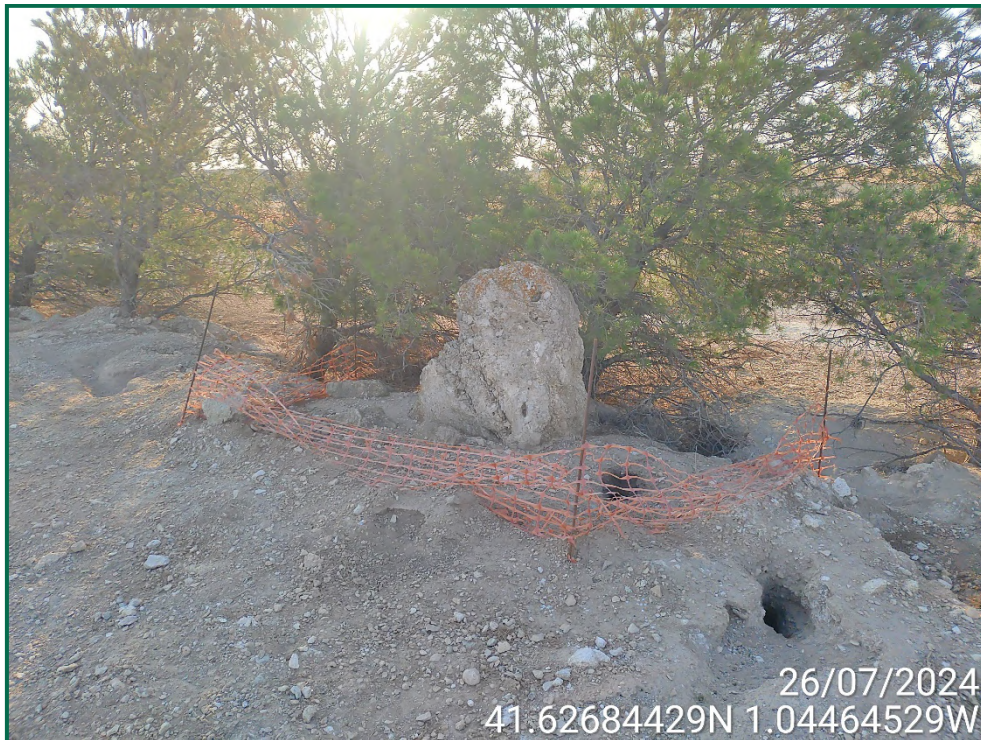
Fotografía 23. Balizado en la línea de evacuación.
