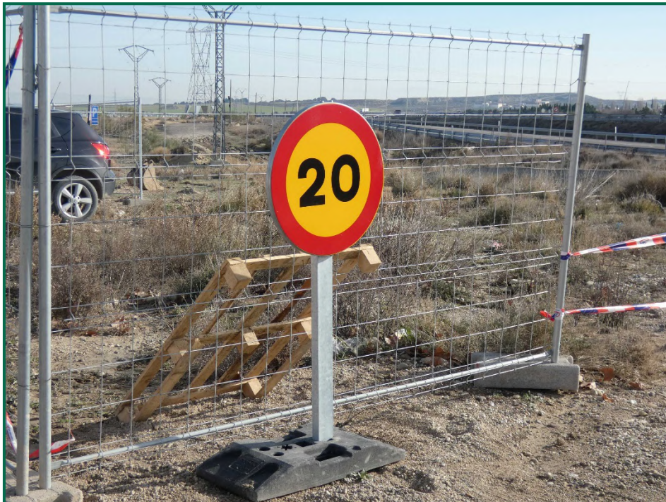
Fotografía 2. Señalización de velocidad.
