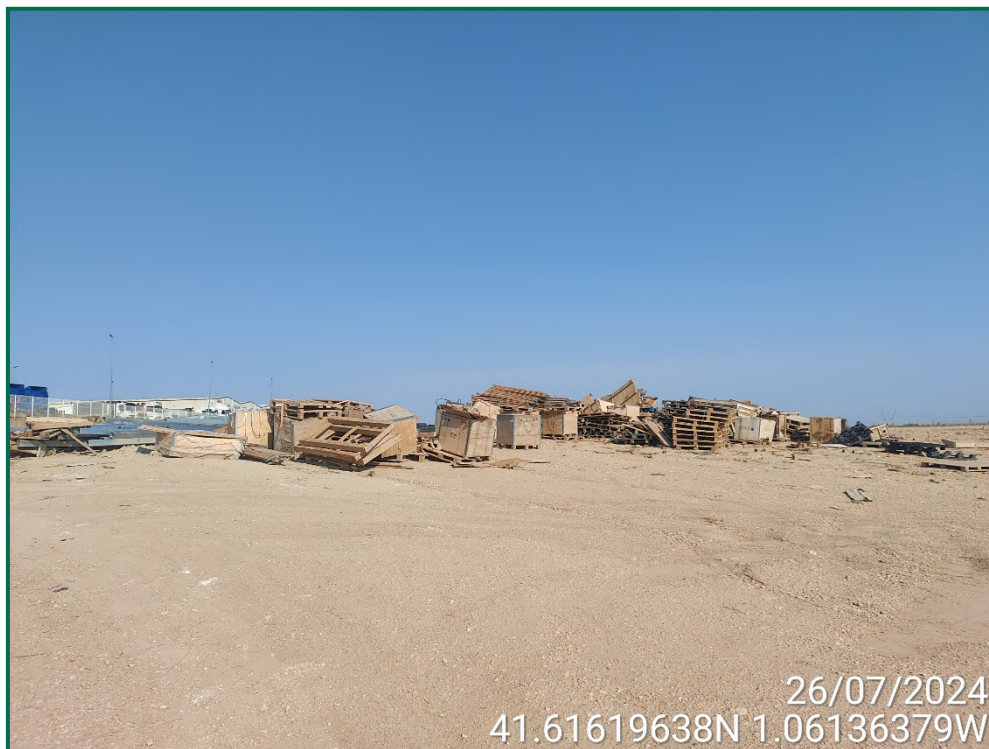
Fotografía 16. Restos de materiales.
