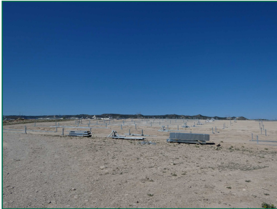
Fotografía 4. Superficie de la obra.
