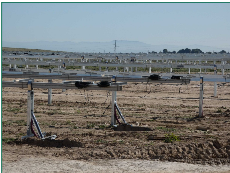
Fotografía 5. Colocación de postes verticales y horizontales para las placas fotovoltaicas.
