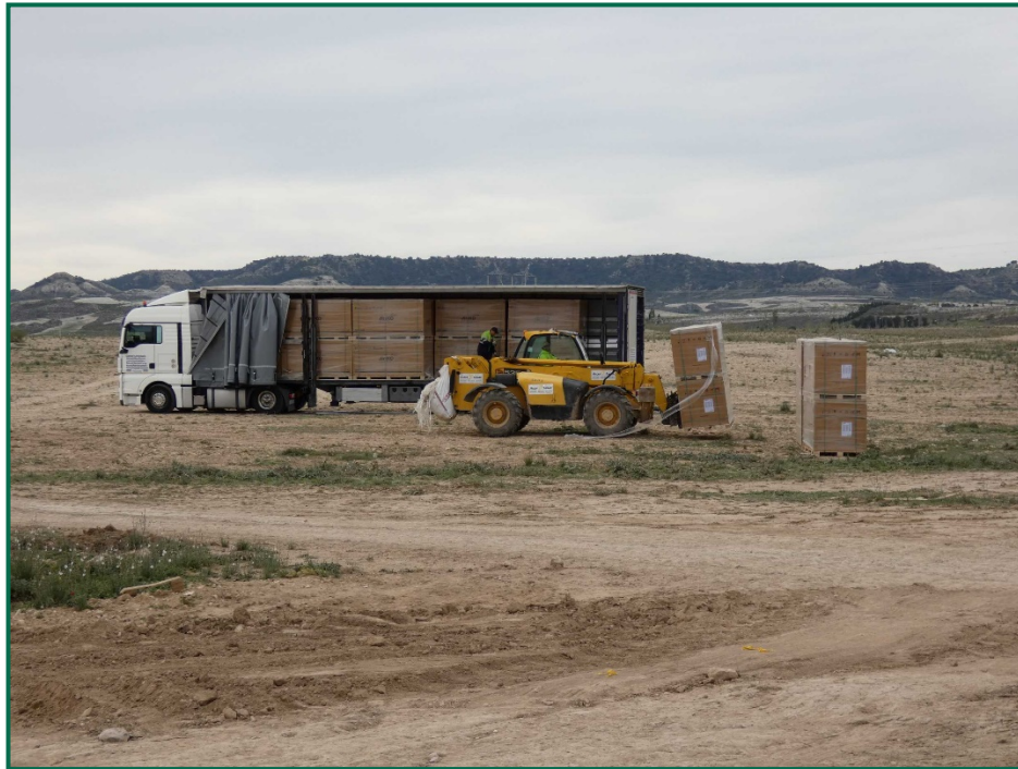
Fotografía 6. Recepción de materiales.
