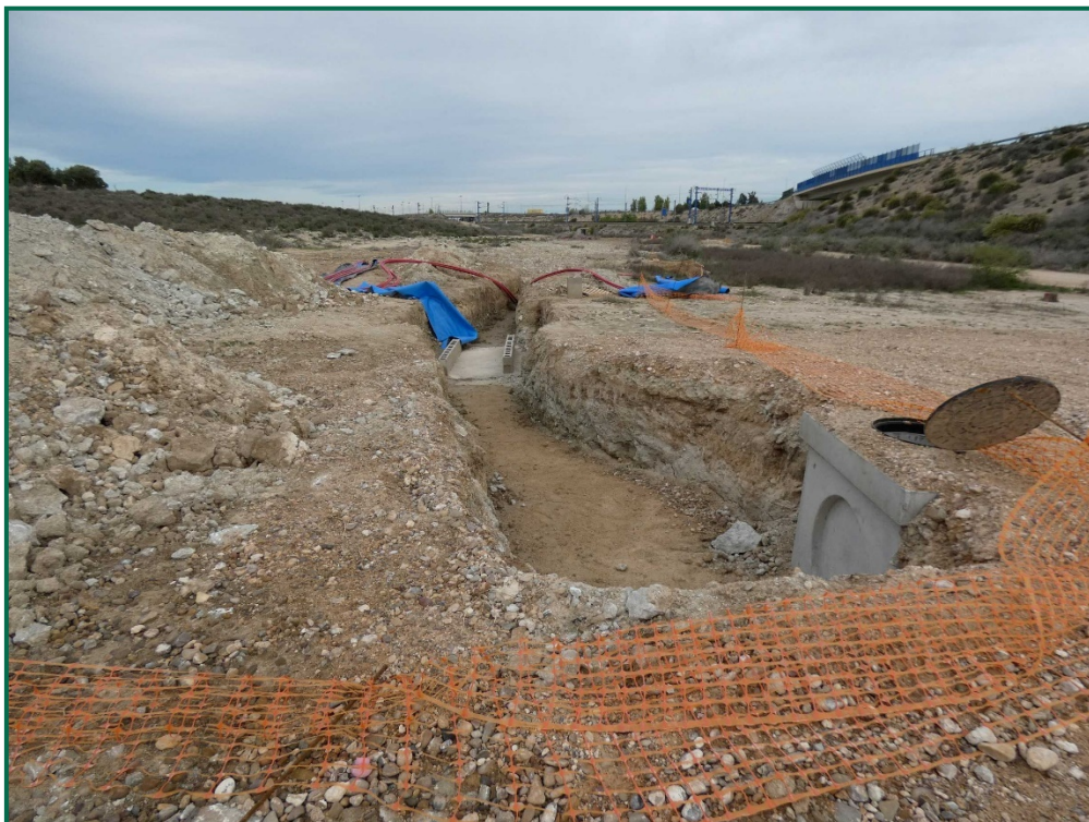
Fotografía 29. Balizamiento de la zanja.
