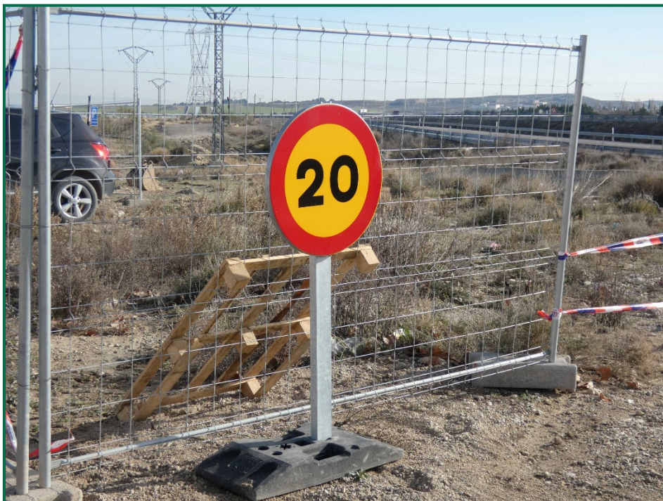
Fotografía 2. Señalización de velocidad.
