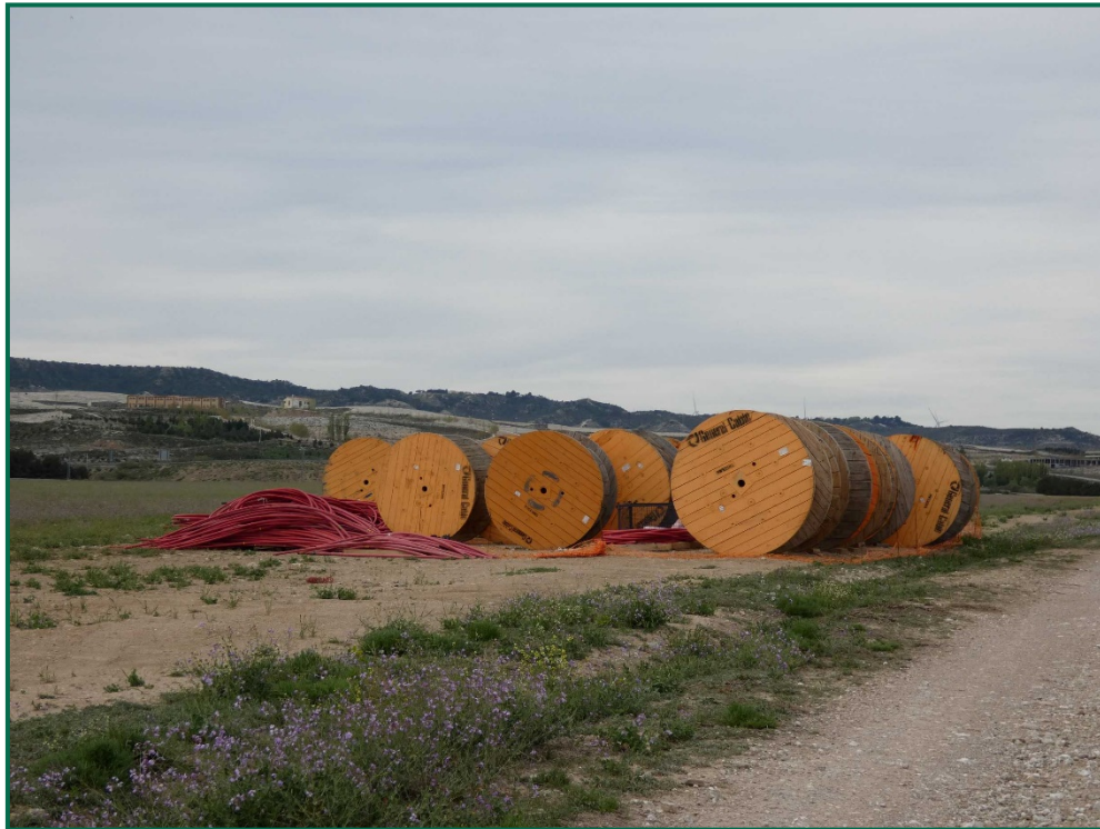
Fotografía 32. Bobinas de cable utilizadas.
