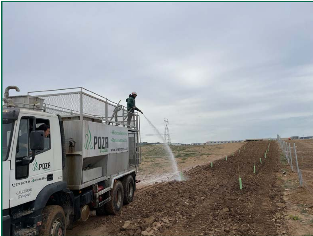
Fotografía 26. Riegos de apoyo.
