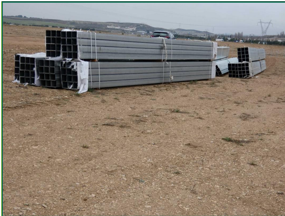
Fotografía 7. Recepción de postes horizontales.
