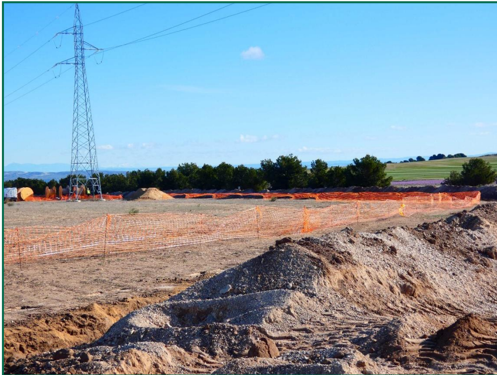
Fotografía 25. Balizamiento de la zanja.
