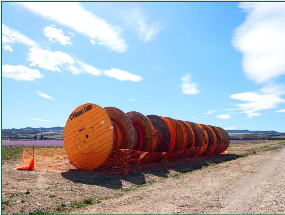
Fotografía 27. Balizado de las bobinas del cableado.
