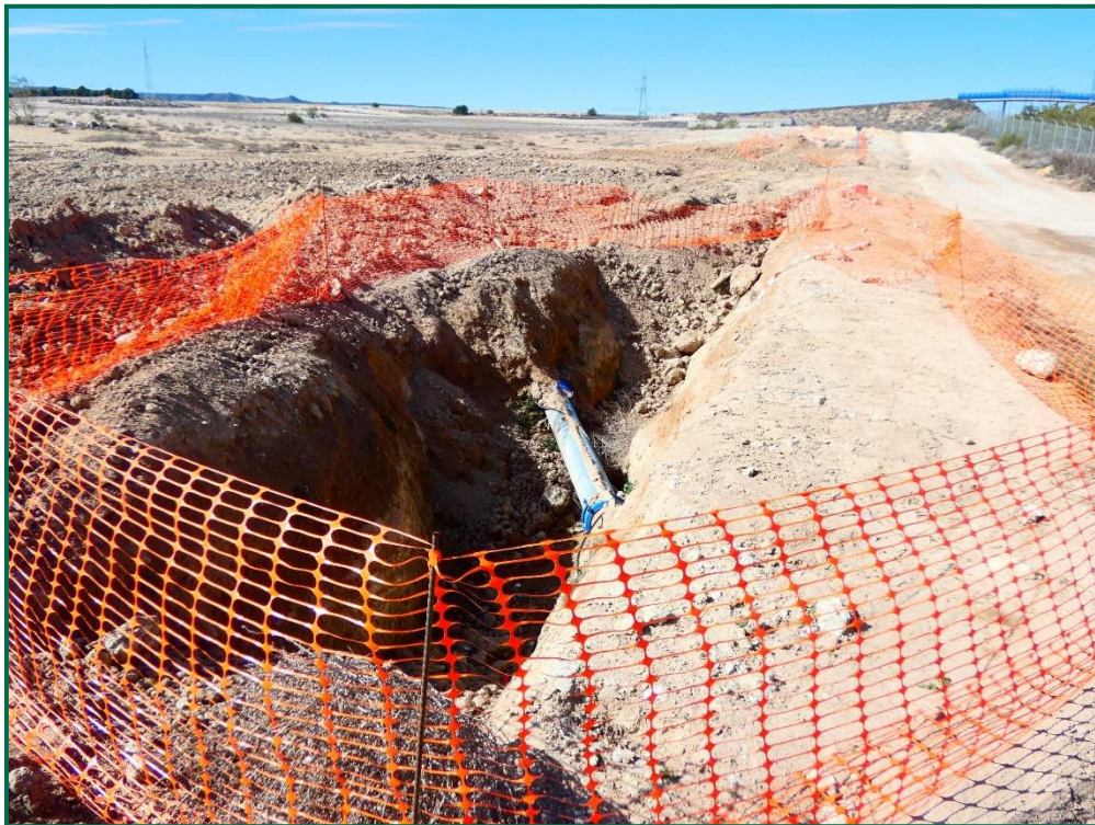
Fotografía 26. Descubrimiento de gasoducto y balizado de zanja.
