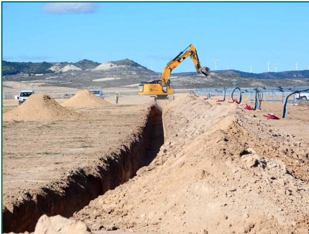
Fotografía 28. Realización de zanjas y acopios de tierra.
