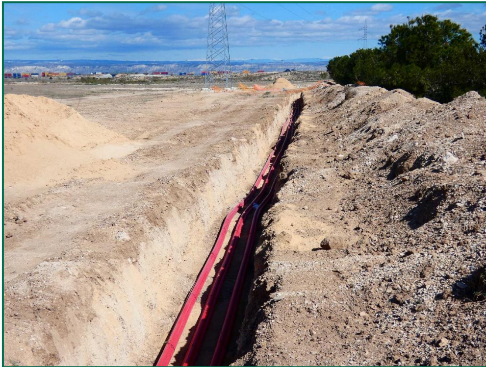
Fotografía 29. Colocación de cableado.
