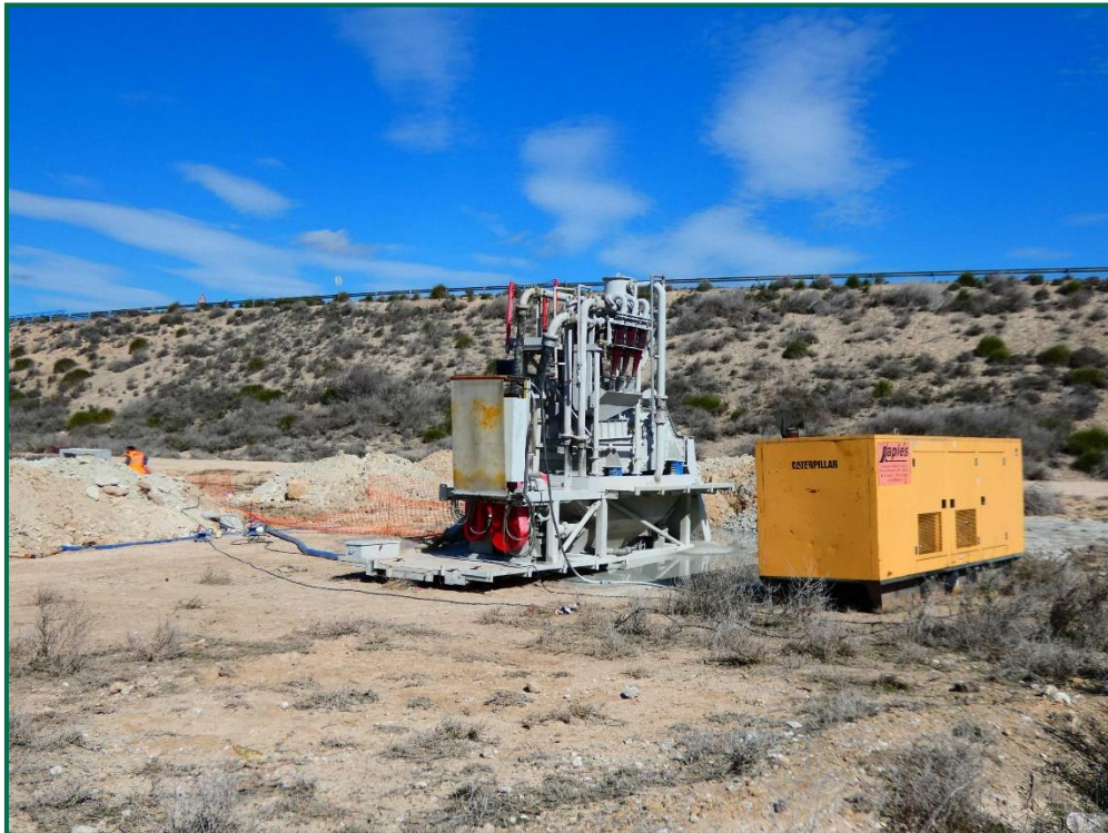
Fotografía 31. Final de la línea de evacuación.
