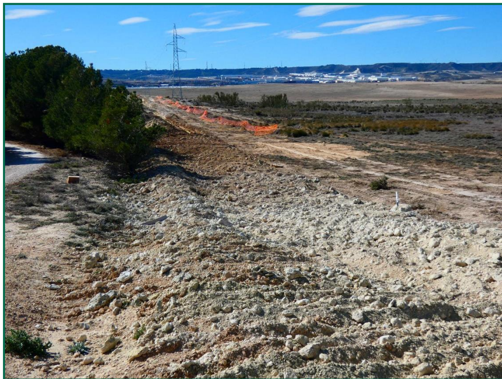
Fotografía 30. Tapado de zanjas.
