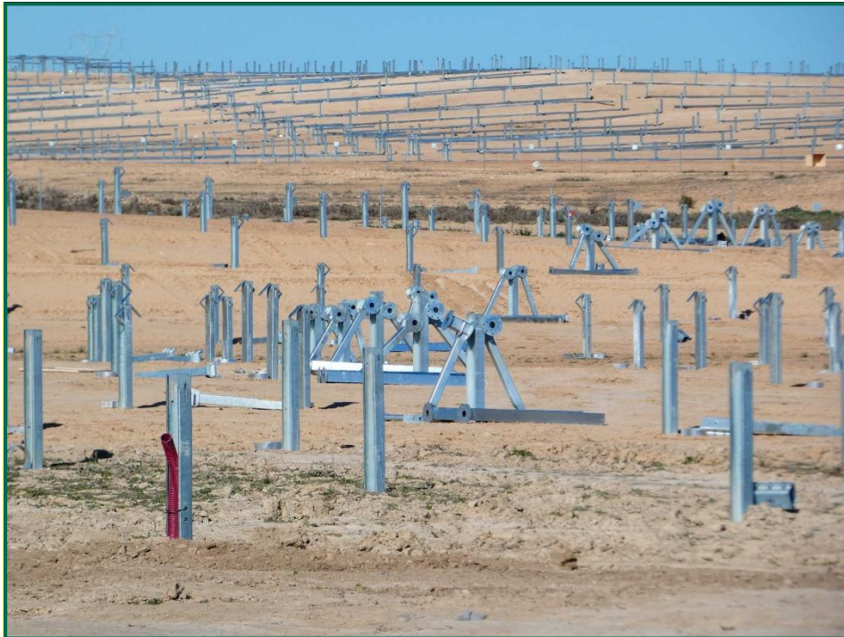
Fotografía 6. Colocación de postes verticales y horizontales para las placas fotovoltaicas.
