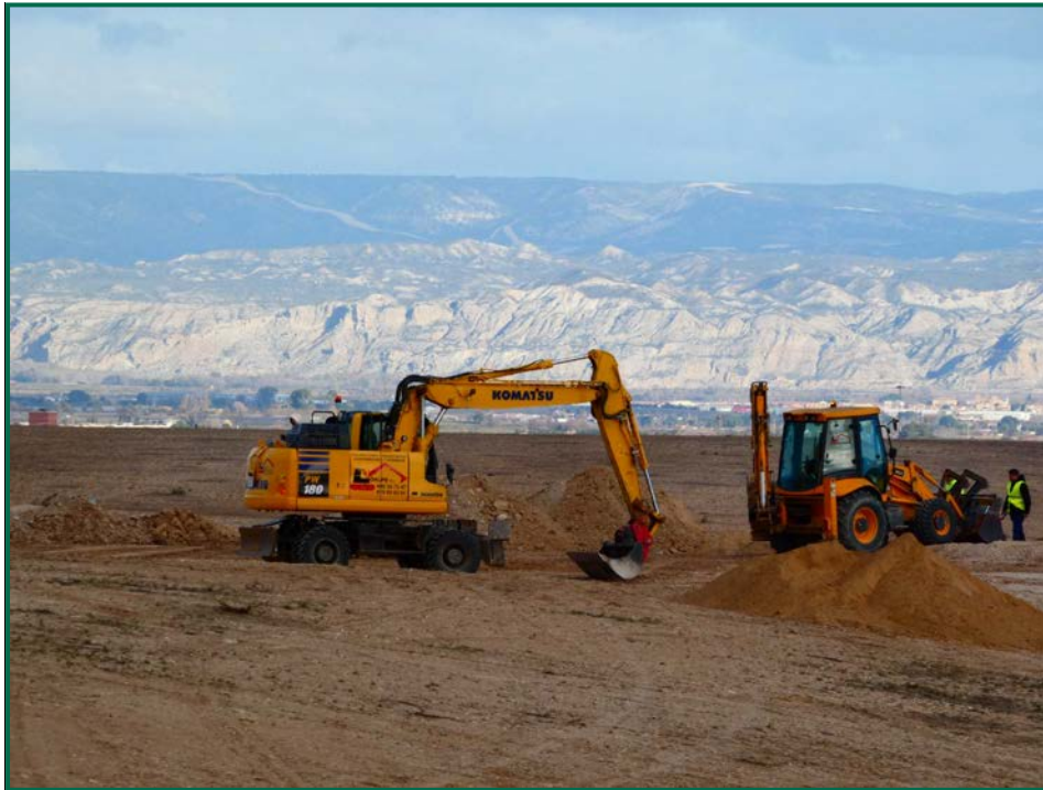
Fotografía 4. Máquina escavadora y acopios de tierra.
