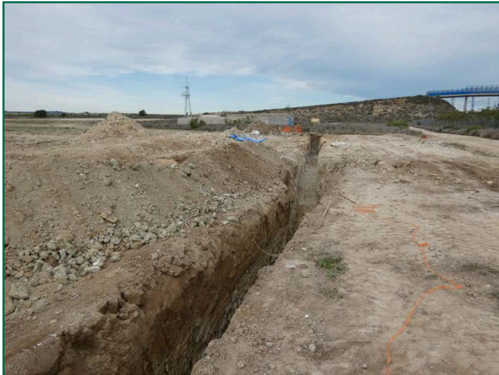
Fotografía 30. Realización de zanjas y acopios de tierra.
