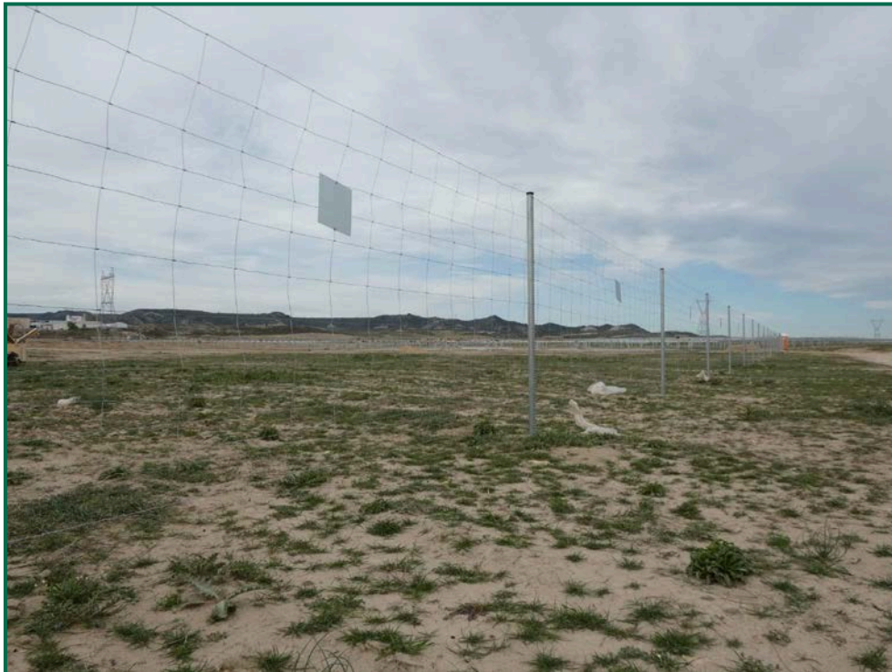
Fotografía 10. Placas anticolidión y vallado perimetral.
