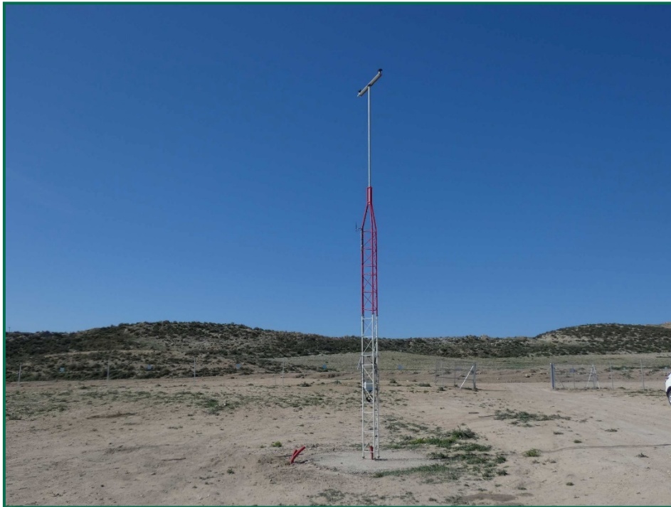
Fotografía 6. Estructura para parámetros medioambientales.
