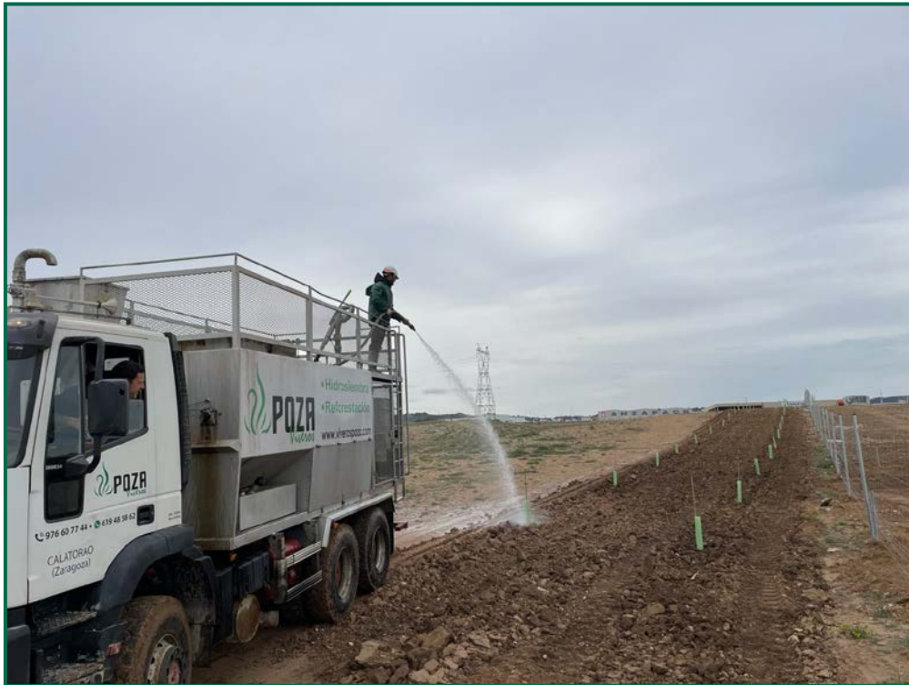
Fotografía 26. Riegos de apoyo.
