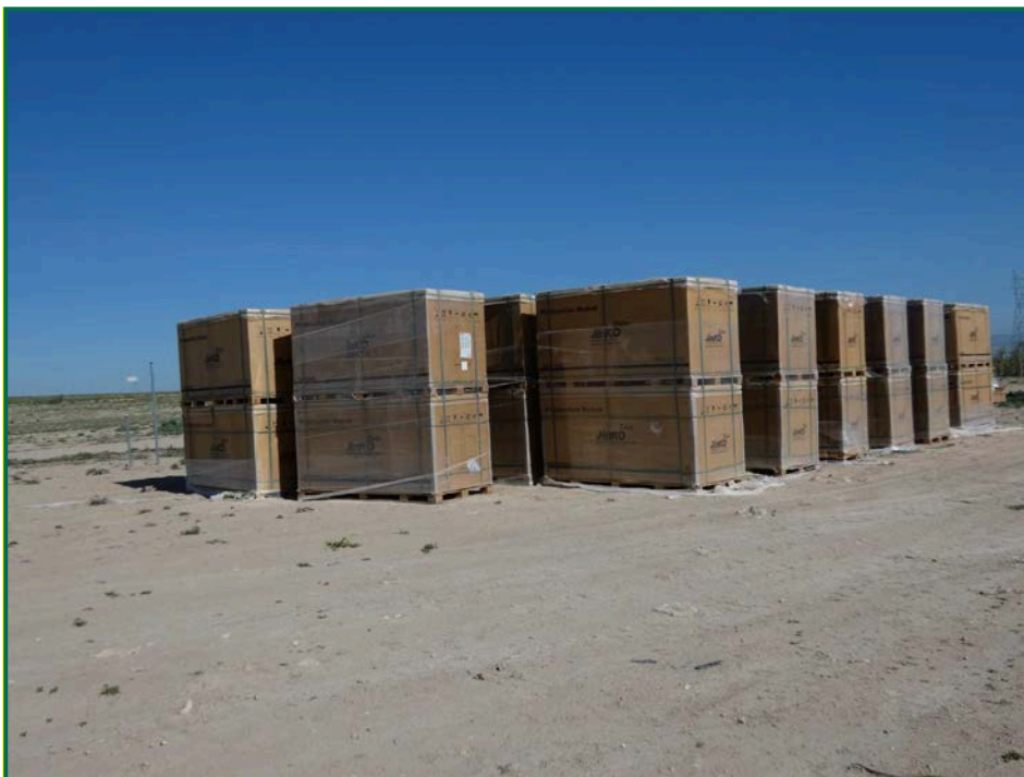
Fotografía 5. Materiales de obra.
