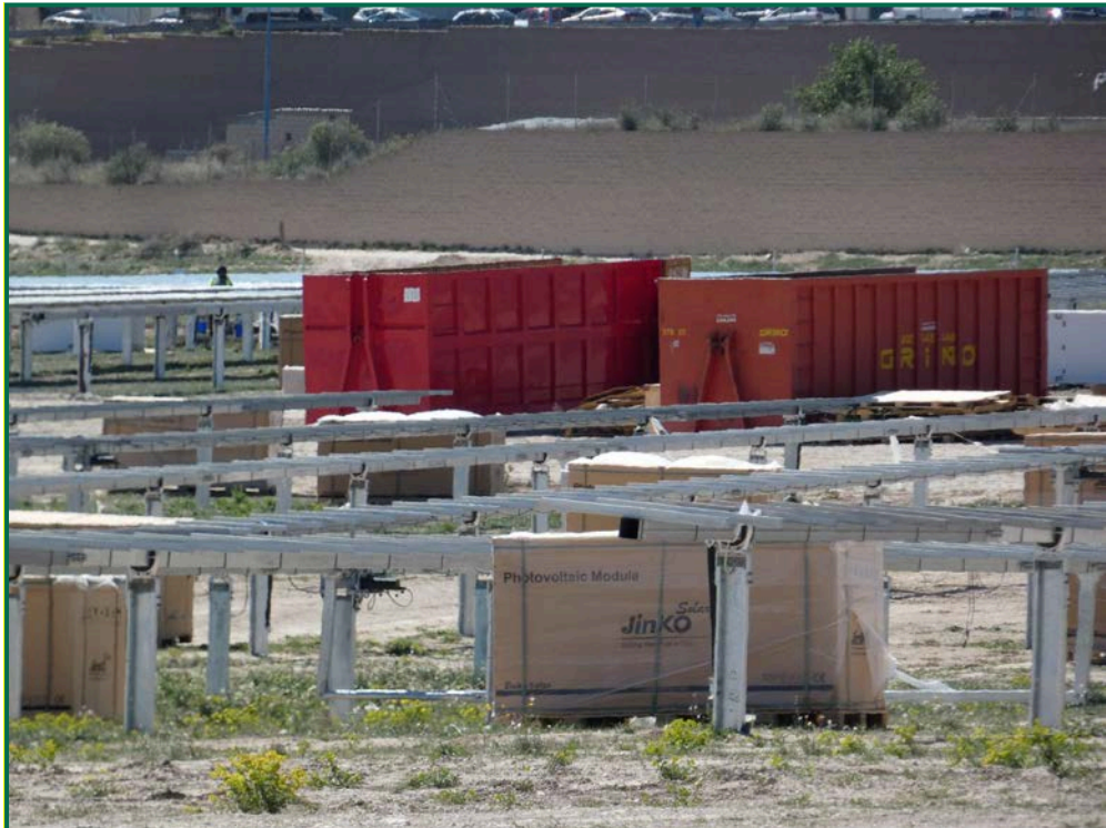
Fotografía 14. Contenedores de residuos.
