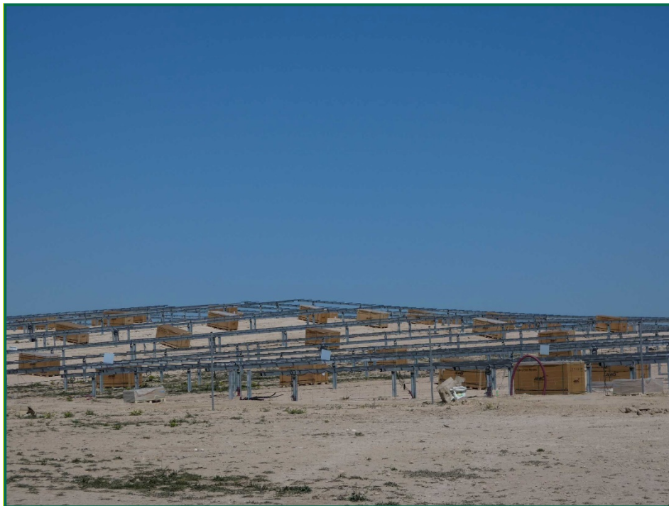
Fotografía 3. Superficie de la obra.
