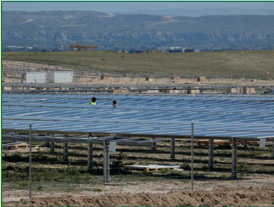
Fotografía 4. Colocación postes horizontales.
