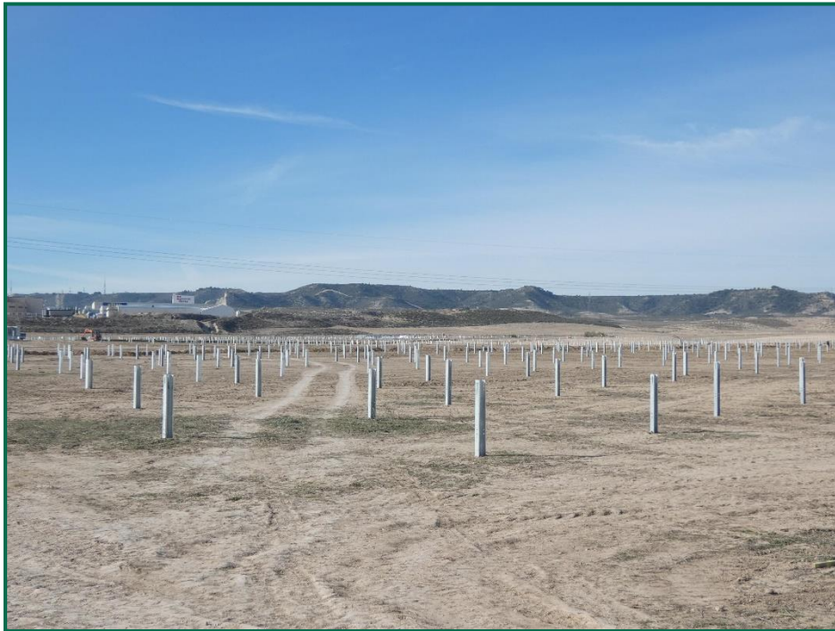
Fotografía 8. Superficie de la planta y postes verticales.
