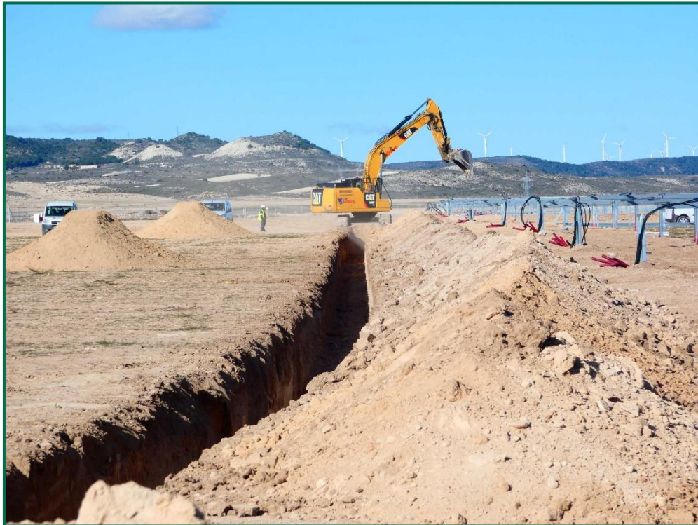
Fotografía 31. Realización de zanjas y acopios de tierra.
