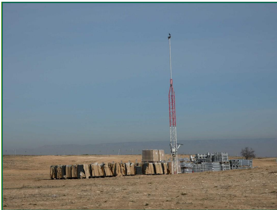
Fotografía 7. Torre de parámetros ambientales y materiales de obra.
