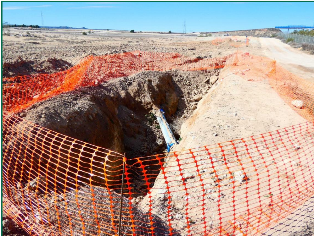
Fotografía 29. Descubrimiento de gasoducto y balizado de zanja.
