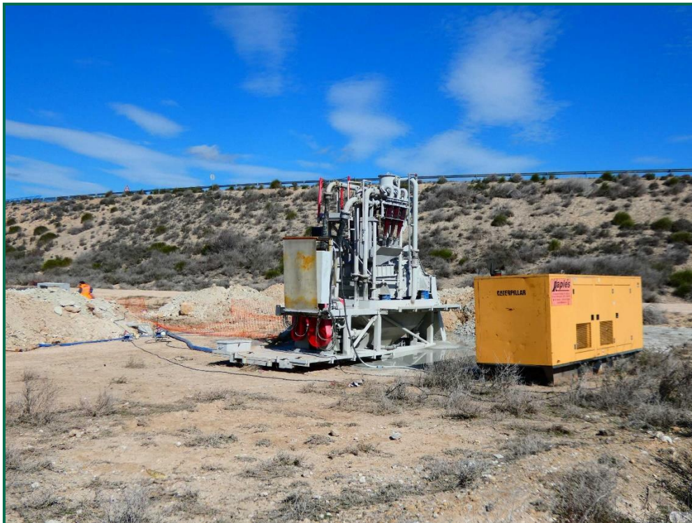
Fotografía 34. Final de la línea de evacuación.
