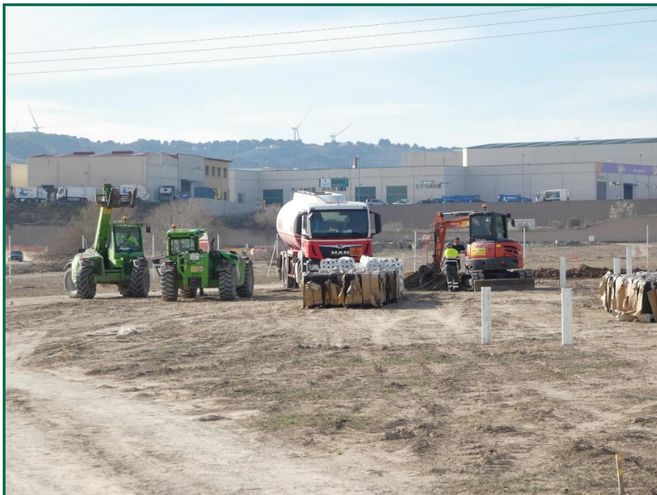
Fotografía 4. Maquinaria de construcción.
