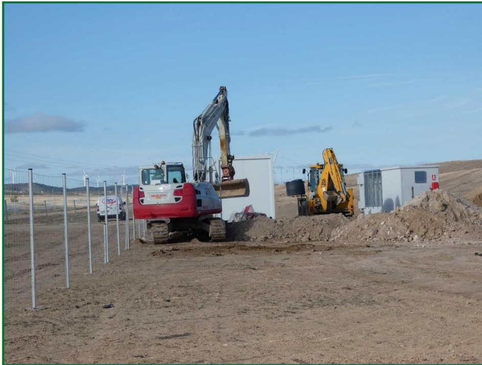
Fotografía 5. Excavadoras tapando zanjas.
