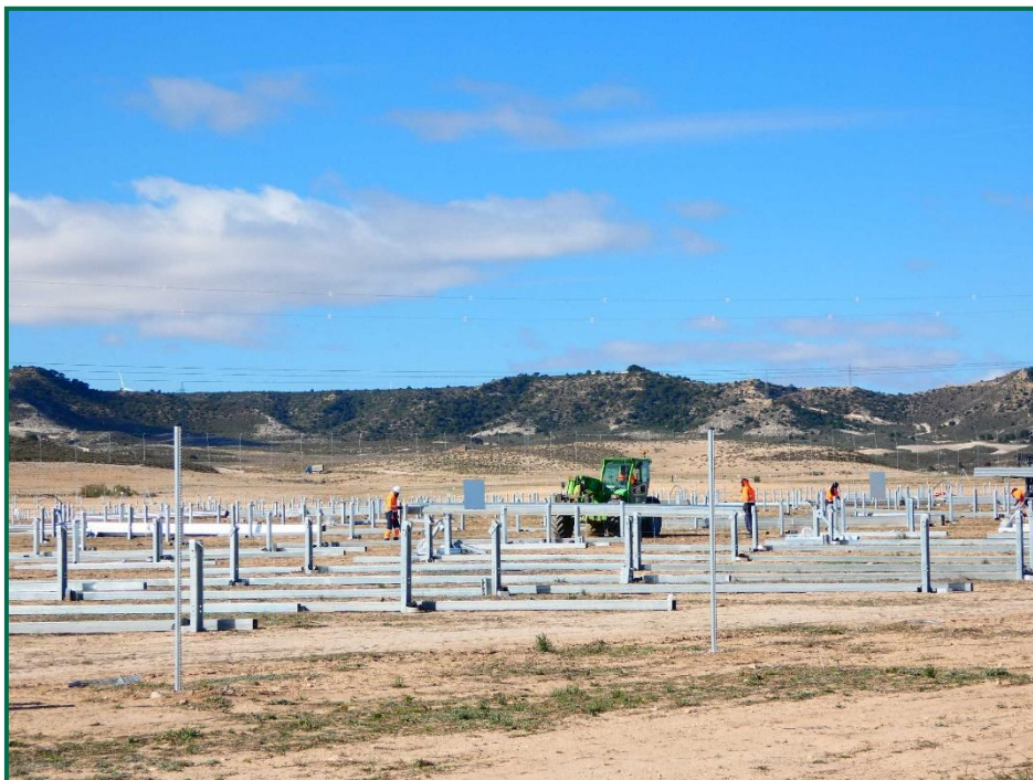
Fotografía 9. Colocación de postes horizontales.
