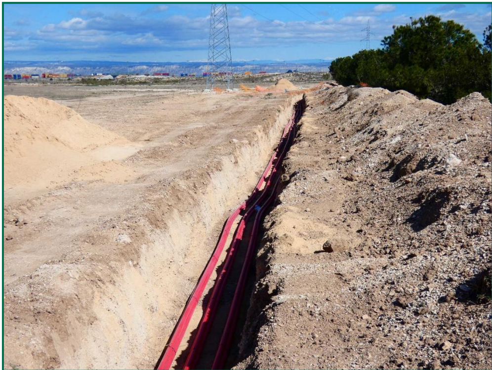
Fotografía 32. Colocación de cableado.
