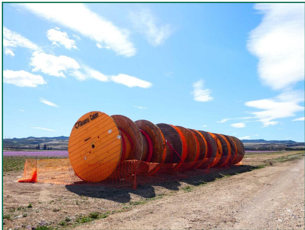
Fotografía 30. Balizado de las bobinas del cableado.
