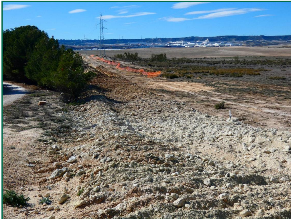
Fotografía 33. Tapado de zanjas.
