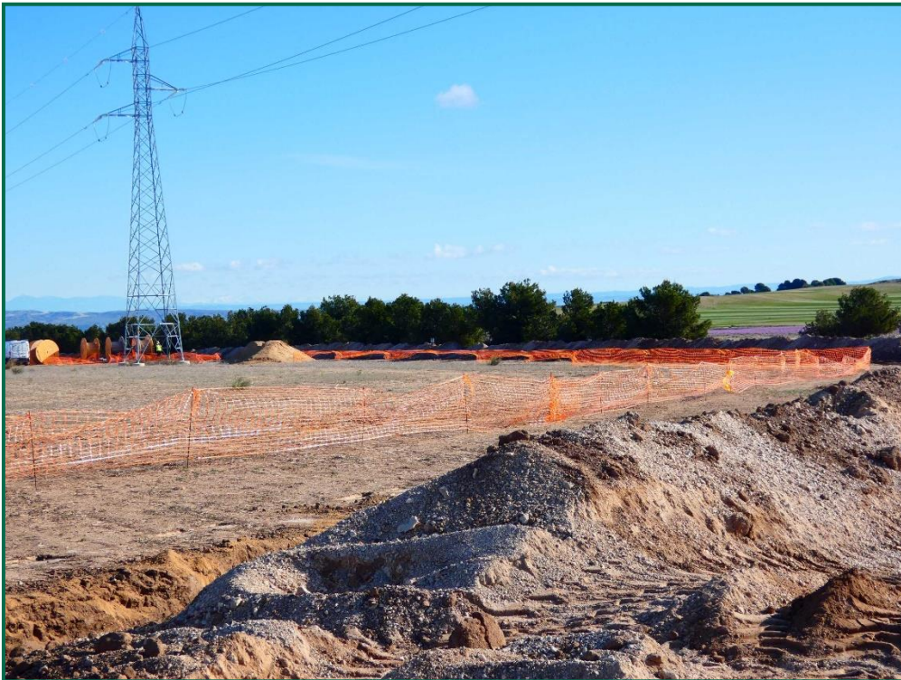
Fotografía 28. Balizamiento de la zanja.
