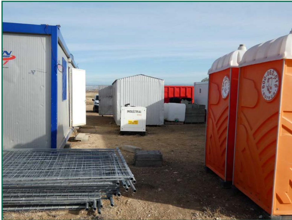
Fotografía 12. Vestuarios, servicios y materiales de obra.
