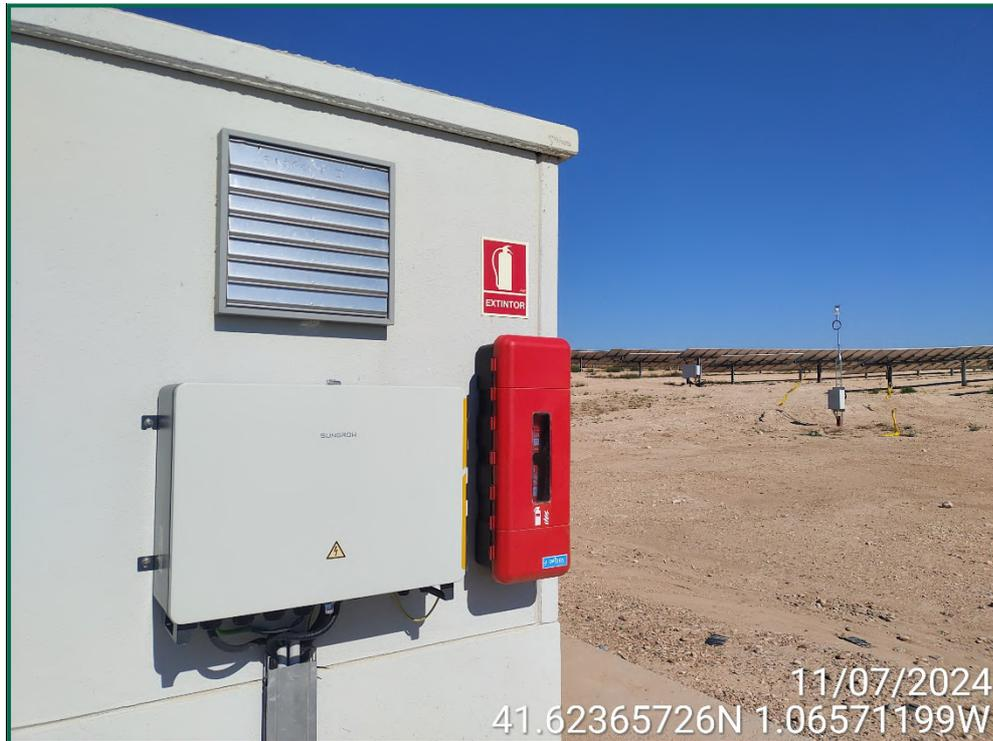
Fotografía 23. Extintor en la caseta del inversor.
