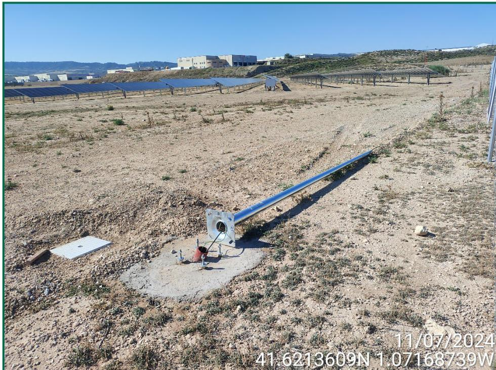
Fotografía 4. Colocación de postes para las cámaras de vigilancia.
