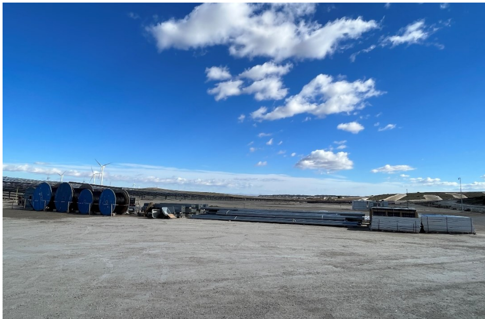
Figura 5 Acopio del material de construcción
