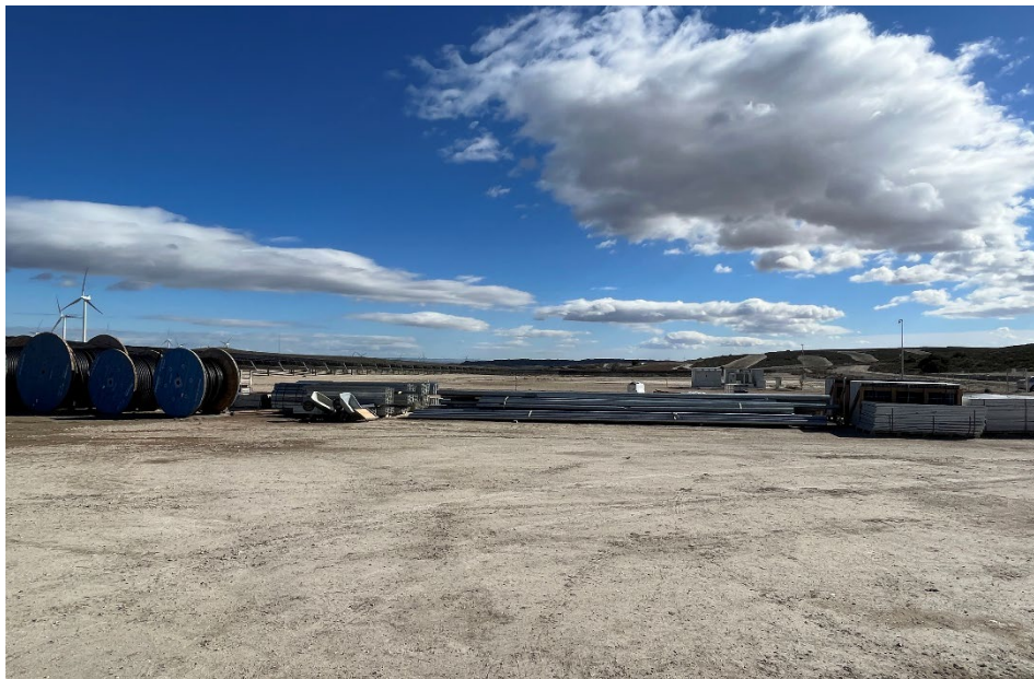
Figura 5 Acopio del material de construcción
