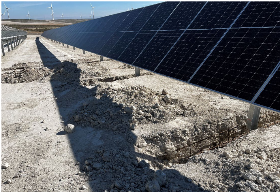
Figura 44 Cimentación de las hincas rechazadas
