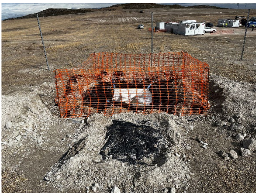
Figura 25 Lavadero de cubas de hormigón
