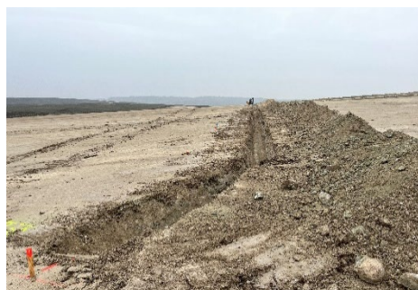
Figura 3 Apertura de zanjas
