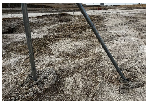
Figura 4 Trabajos de cimentación
