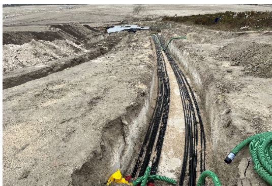
Figura 9 Tendido de cable de baja tensión
