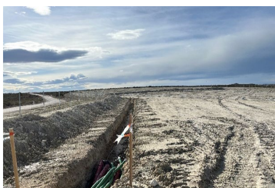
Figura 10 Tendido de cable de media tensión
