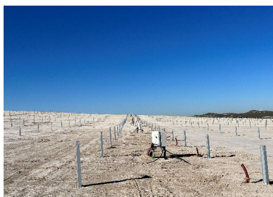
Figura 11 Montaje de los cuadros de control
