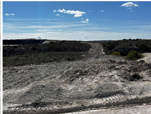
Figura 18 Descompactación del suelo
