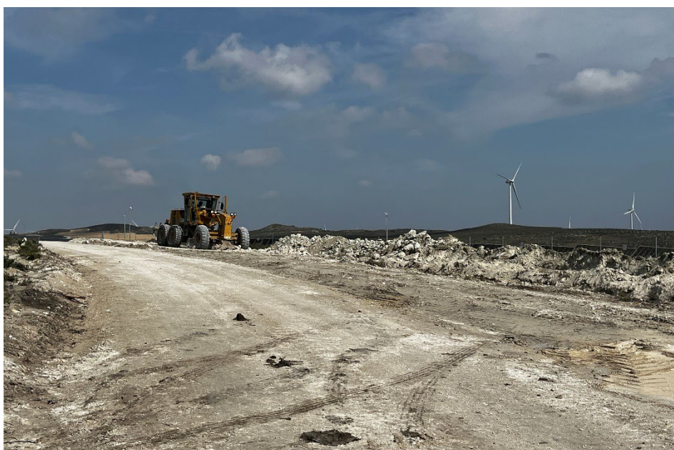
Figura 42 Relleno de la zanja para la media tensión
