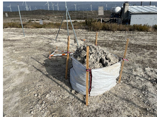
Figura 24 Retirada de los vertidos de hormigón
