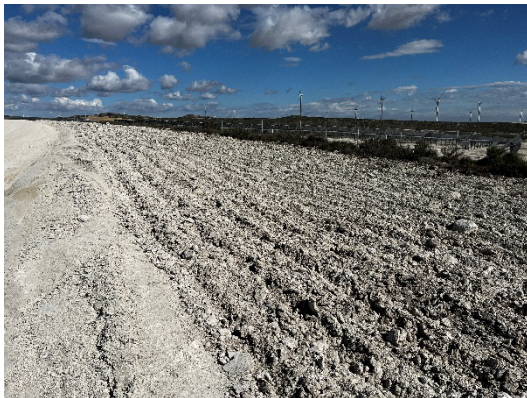
Figura 17 Descompactación del suelo
