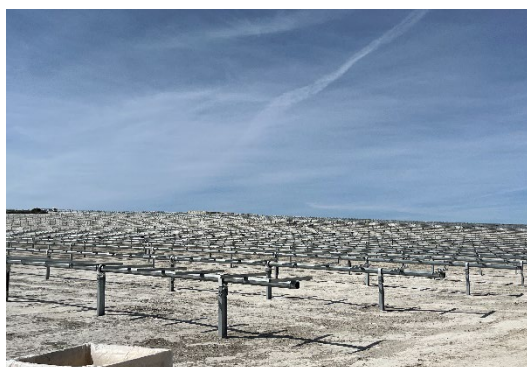
Figura 7 Montaje de los trackers
