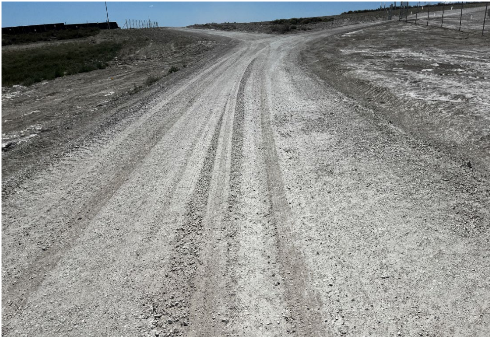
Figura 45 Restauración de los viales
