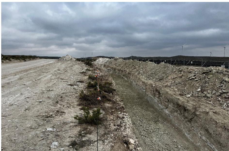
Figura 41 Zanja para la media tensión
