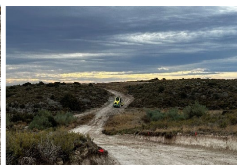
Figura 5 Apertura de viales
