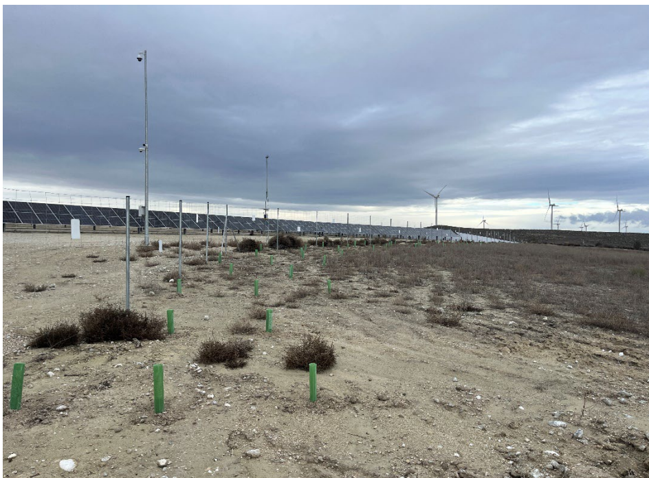
Figura 12 Vallado perimetral y pantalla vegetal
