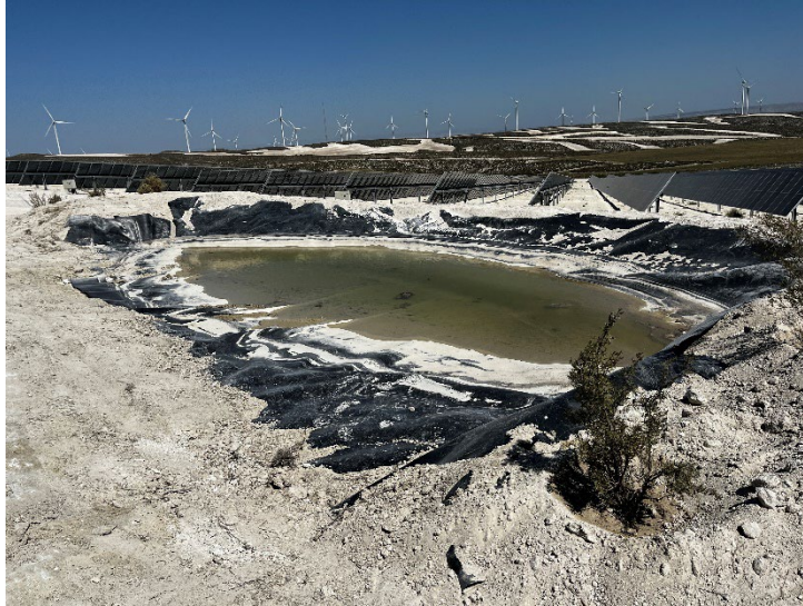
Figura 7 Balsete con acumulación de agua
