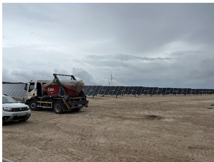
Figura 2 Retirada del punto limpio de residuos no peligrosos
