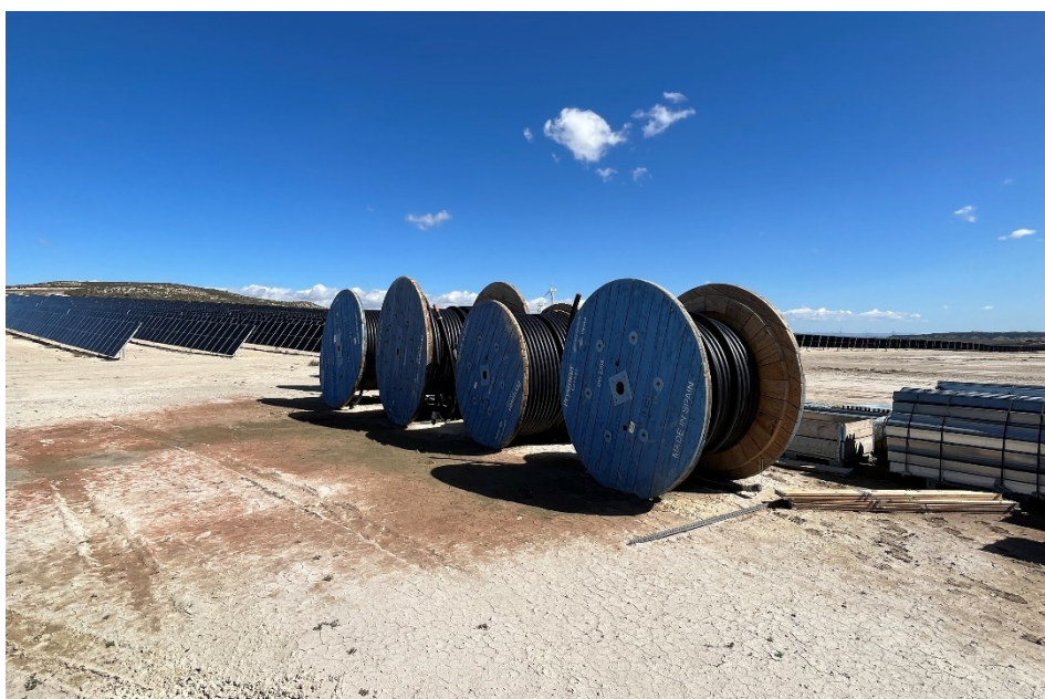
Figura 7 Acopio del material de construcción
