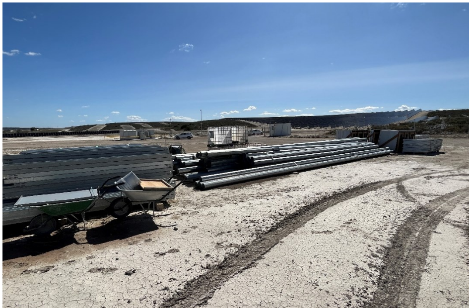
Figura 6 Acopio del material de construcción
