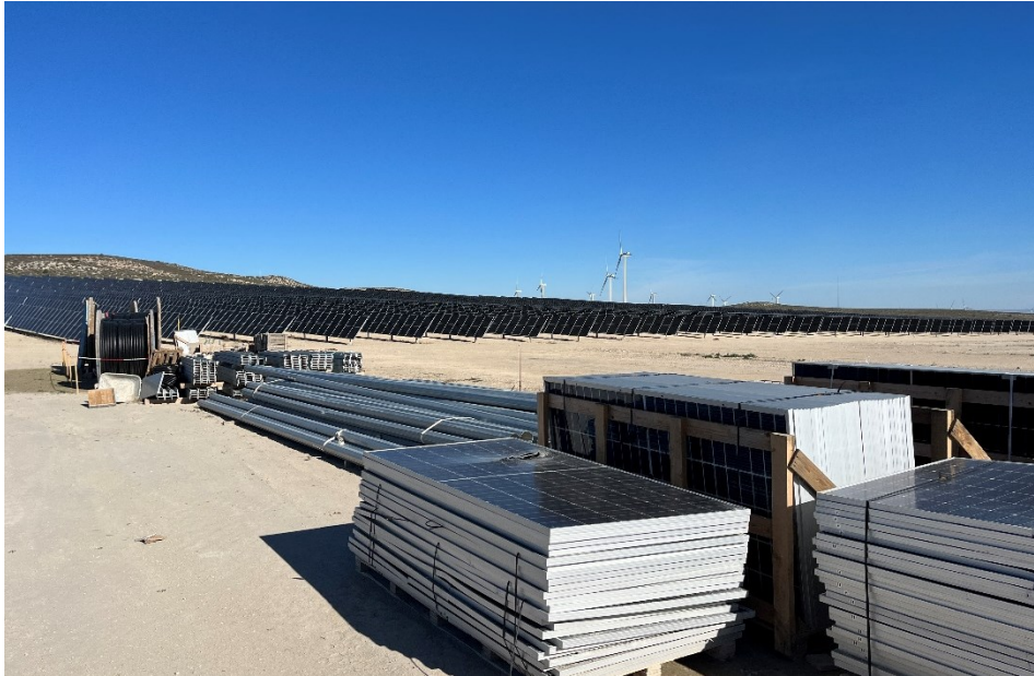
Figura 5 Acopio del material de construcción
