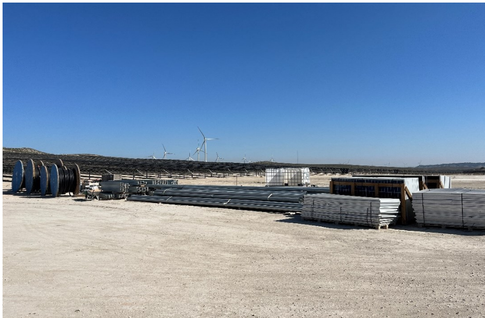
Figura 5 Acopio del material de construcción
