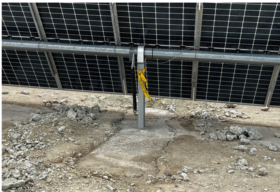
Figura 41 Cimentación de las hincas rechazadas
