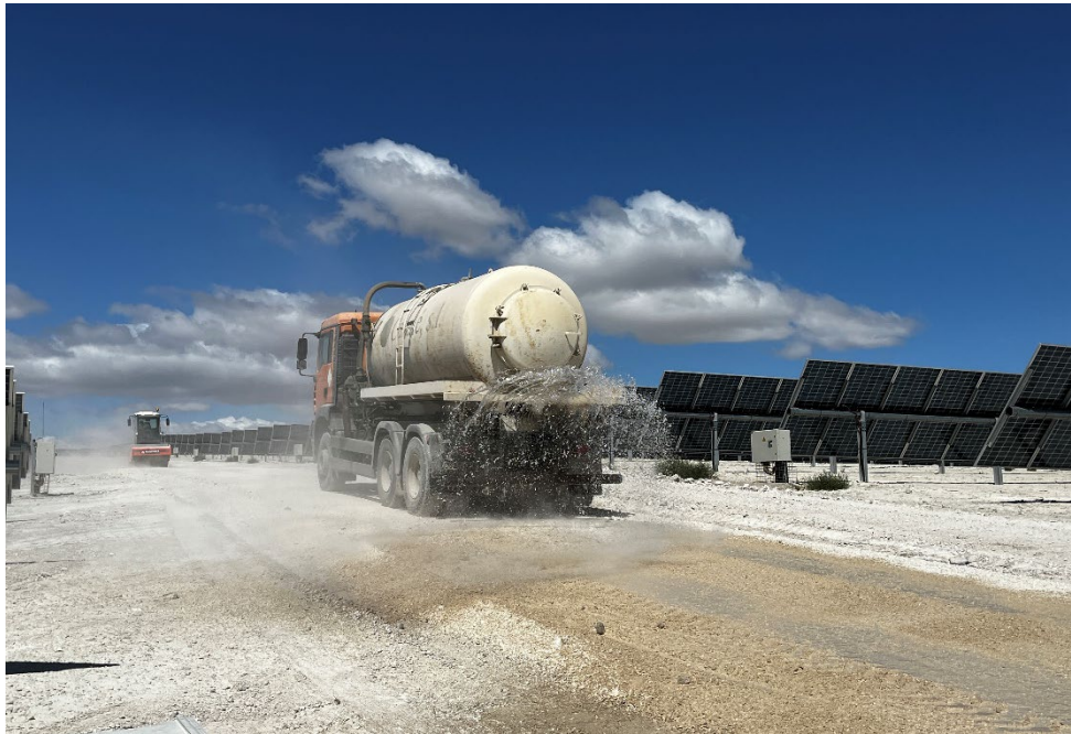
Figura 42 Restauración de los viales
