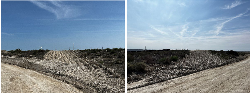
Figura 15 Restauración de accesos temporales
