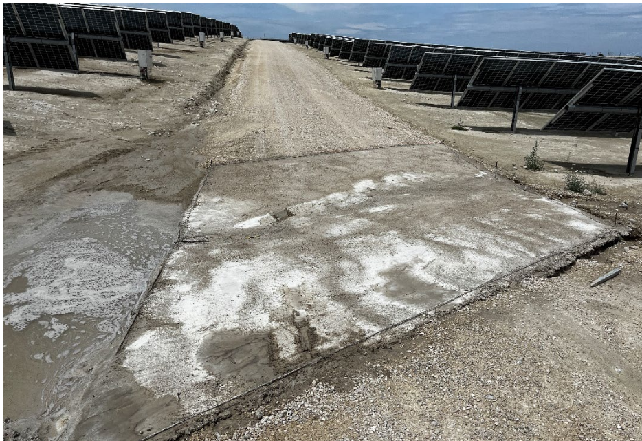
Figura 40 Cimentaciones del vial interno
