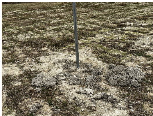
Figura 21 Pequeños vertidos de hormigón
