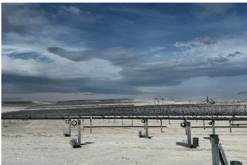
Figura 39 Montaje de los trackers
