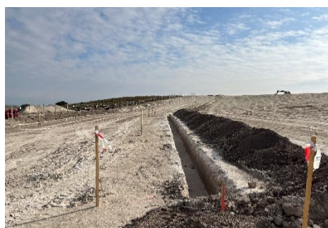
Figura 3 Apertura de zanjas
