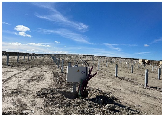
Figura 11 Montaje de los cuadros de control
