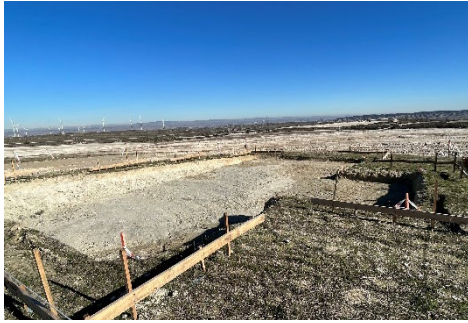
Figura 4 Trabajos de cimentación
