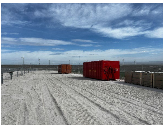
Figura 24 Punto limpio de RNP del PSFV
