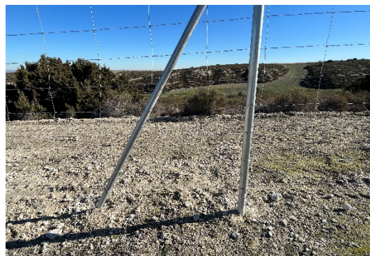
Figura 37 Paso de fauna
