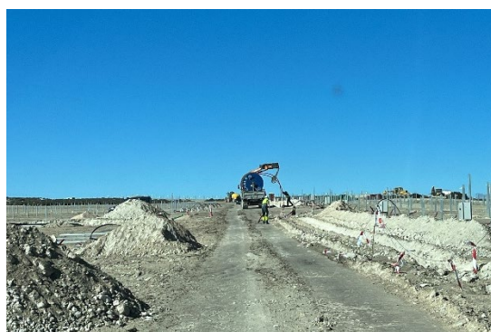
Figura 10 Tendido de cable de media tensión
