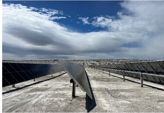
Figura 8 Montaje de los módulos fotovoltaicos
