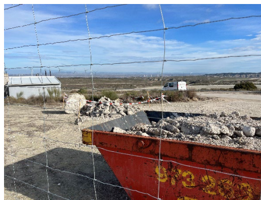
Figura 22 Retirada de los vertidos de hormigón
