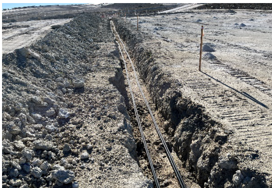
Figura 9 Tendido de cable de baja tensión
