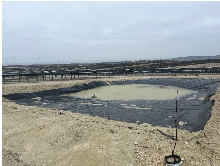
Figura 7 Balsete con acumulación de agua
