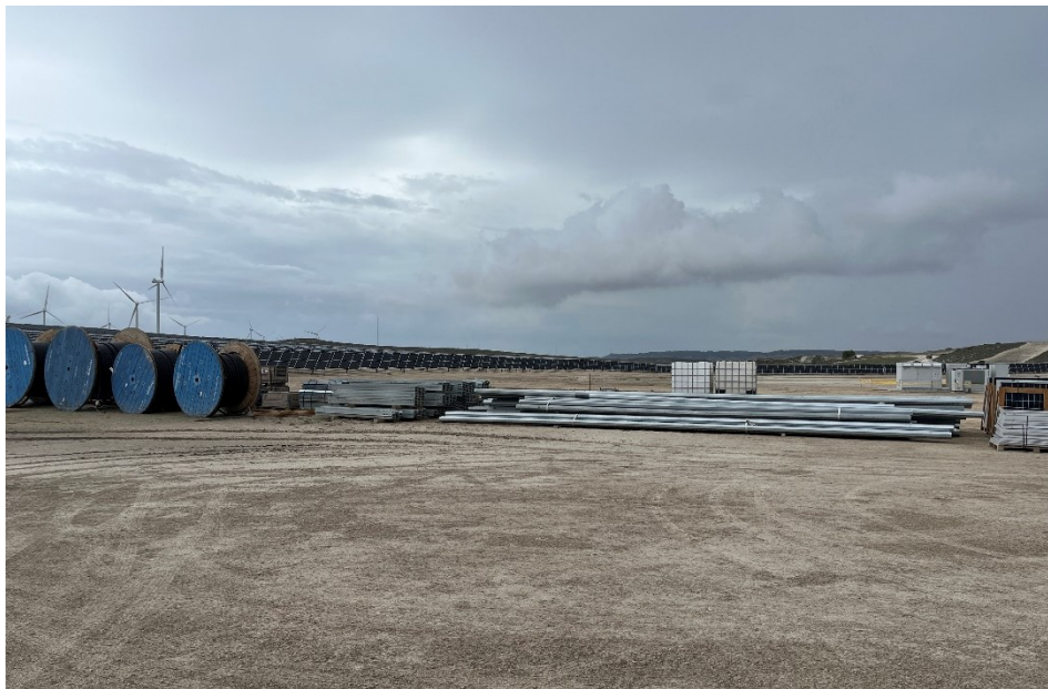
Figura 6 Acopio del material de construcción
