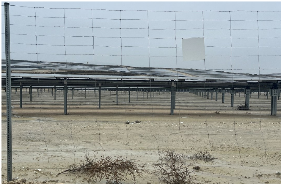
Figura 9 Estado de la vegetación bajo los módulos
