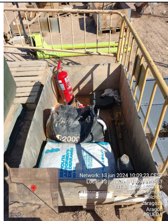
Punto limpio. Zona de repostaje. Cartelería deteriorada.
