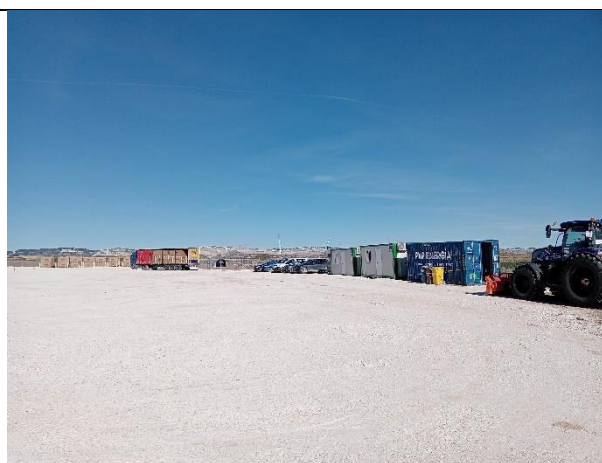
Zona de acopio 1, con las oficinas, zona de aparcamiento de coches de operarios y maquinaria de obra, así como las casetas y zona de punto limpio.
