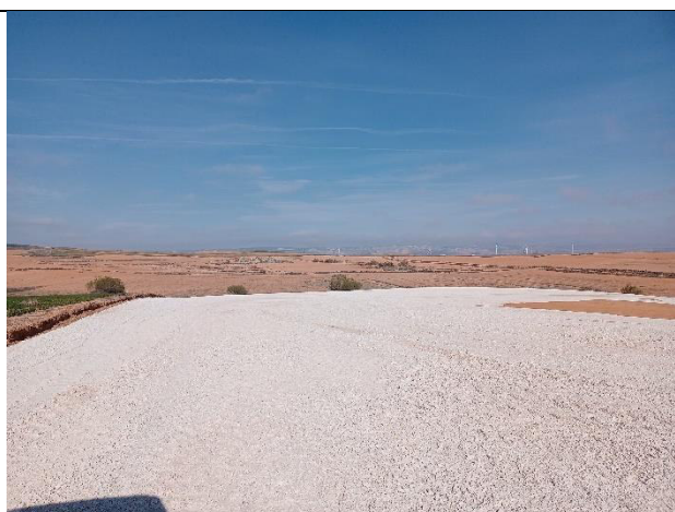
Zona de acopio 3 en proceso de realizacion. Desde parte alta.
