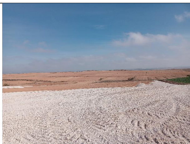
Zona de acopio 3 en proceso de realizacion. Desde parte alta.
