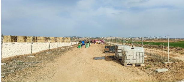
Zona de acopio 1, de PFV Campo de Belchite I. Con mayor cantidad de tubos y arquetas.
