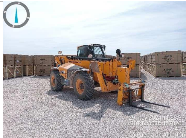
Área de acopio III de paneles solares con la maquinaria para mover los paneles.
