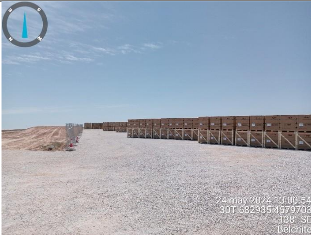
Área de acopio de paneles solares en zona II.
