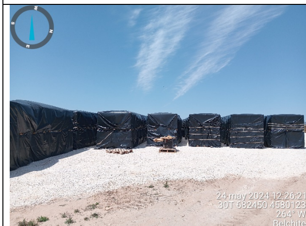
Área de acopio I de paneles solares, cubiertos por lona.
