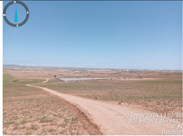
Área de acopio de paneles solares en zona III.
