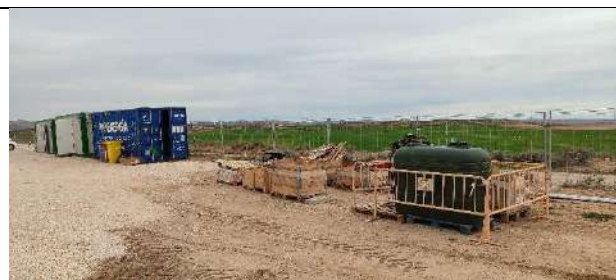
Punto limpio en la zona de acopio 1 y área temporal de repostaje
