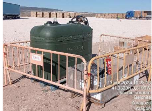
Zona de repostaje temporal en la zona de acopio 1.
