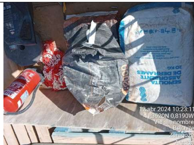
Zona de repostaje temporal en la zona de acopio 1. Sepiolita y extintor.
