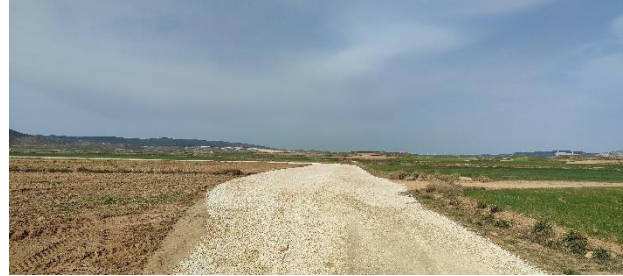
Campa conjunta para futuras infraestructuras auxiliares.
