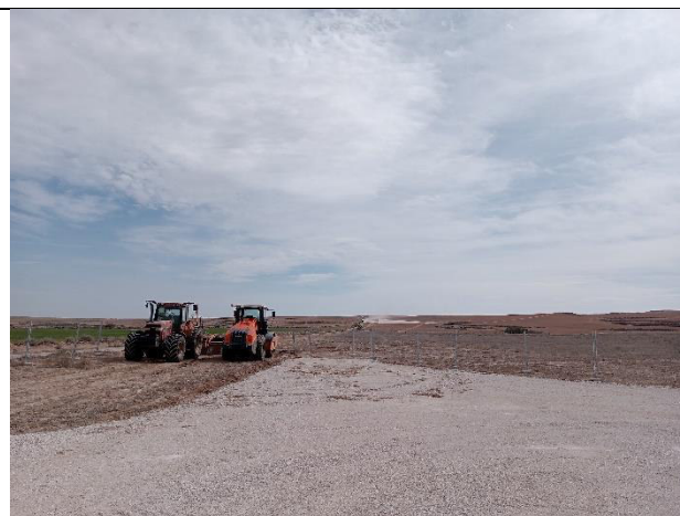
Zona de acopio 3 en proceso de realizacion. Desde la entrada.
