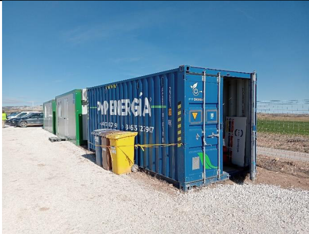
De izquierda a derecha, baños (no visible), oficina, área de descanso y taquillas del personal, almacén de herramienta y punto limpio.
