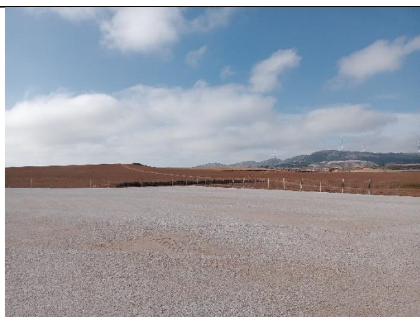
Zona de acopio 2 terminada.
