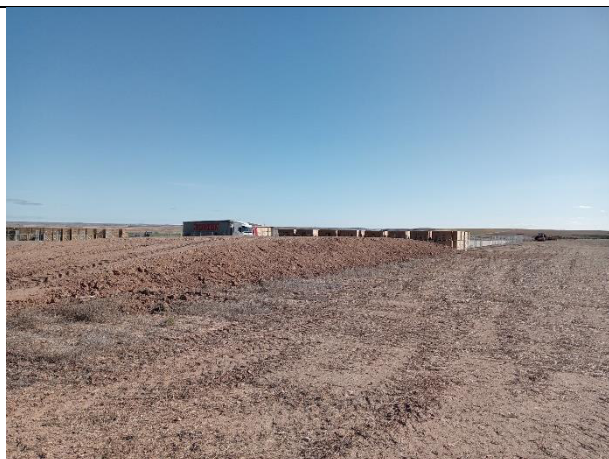
Detalle de la tierra vegetal recuperada de la explanación del terreno, acumulada para su posterior uso en el plan de restauración.
