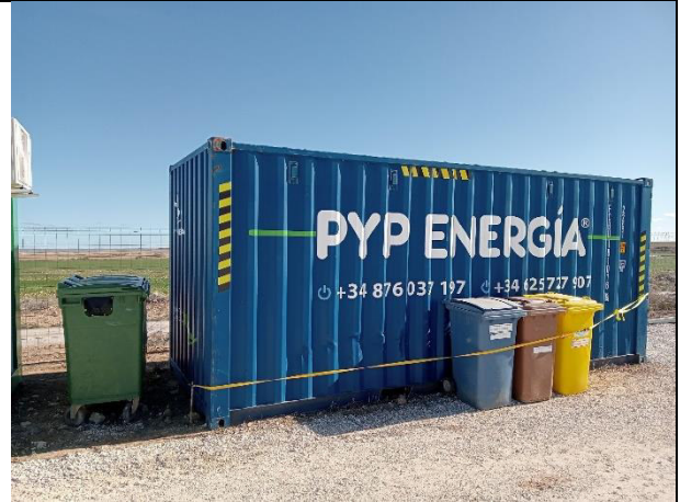
Detalle del punto limpio y almacén de herramientas.
