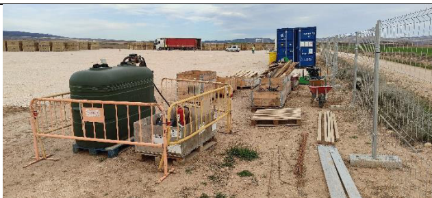
Zona de repostaje temporal.
