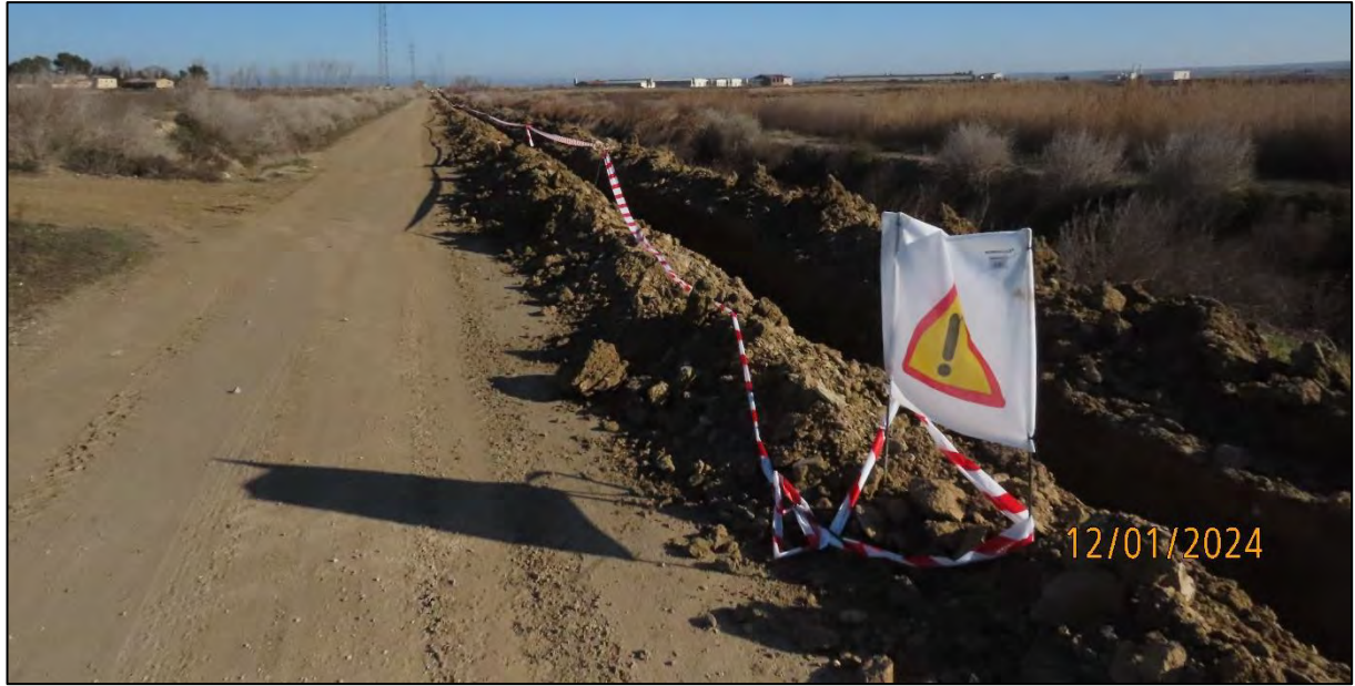
Ilustración 4. Balizamiento de la zona de instalación de la LSMT.
