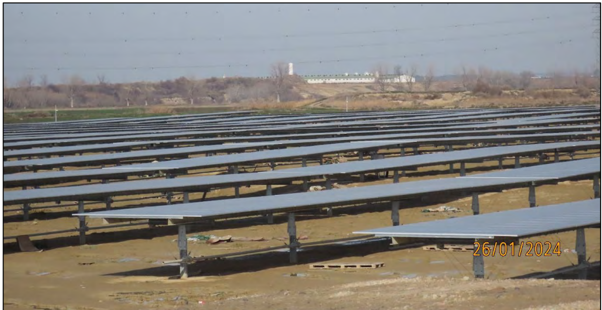
Ilustración 3. Instalación de paneles solares.
