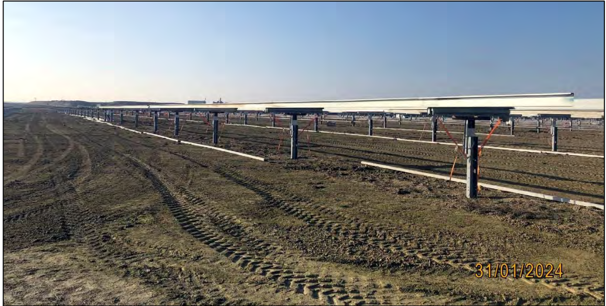
Ilustración 2. Montaje de las estructuras de los seguidores.
