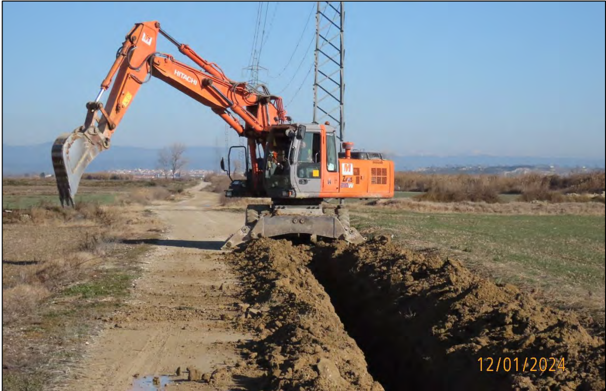
Ilustración 4. Excavación de la zanja para la LSMT.
