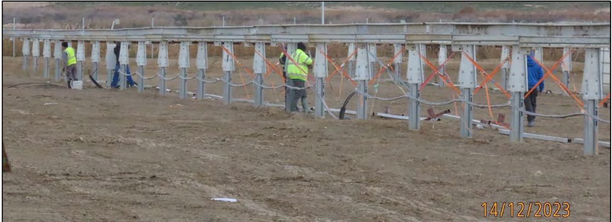
Ilustración 2. Montaje de las estructuras de los seguidores.
