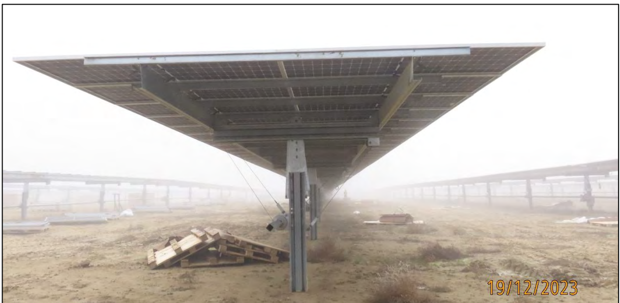
Ilustración 4. Montaje de paneles solares.
