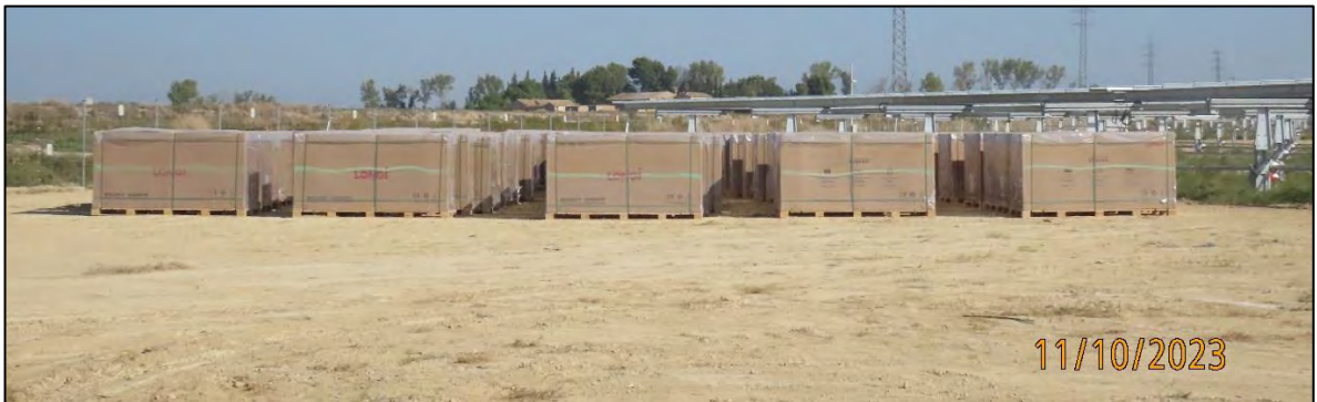
Ilustración 4. Acopio de paneles solares.
