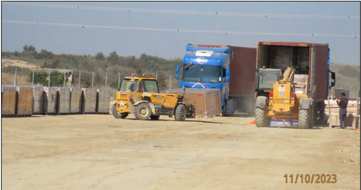
Ilustración 3. Recepción de paneles solares.
