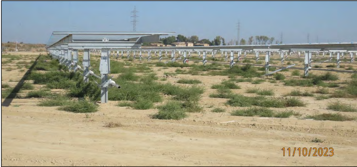
Ilustración 2. Montaje de infraestructuras de los seguidores.
