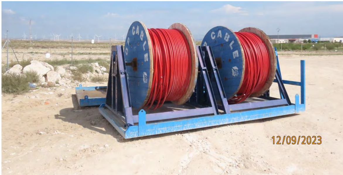
Ilustración 5. Bobinas de cable acopiadas sobre suelo desprovisto de vegetación natural.
