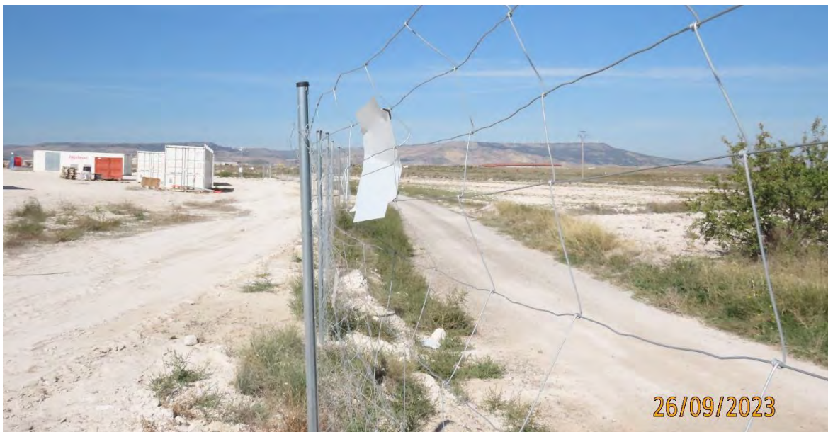
Ilustración 8. Vallado perimetral destensado.
