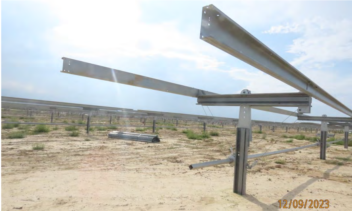
Ilustración 2. Instalación de estructuras de los seguidores.
