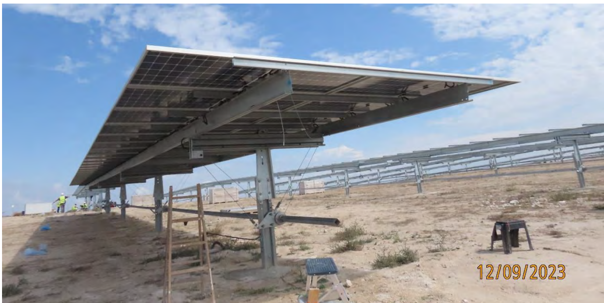
Ilustración 3. Instalación de los paneles fotovoltaicos.
