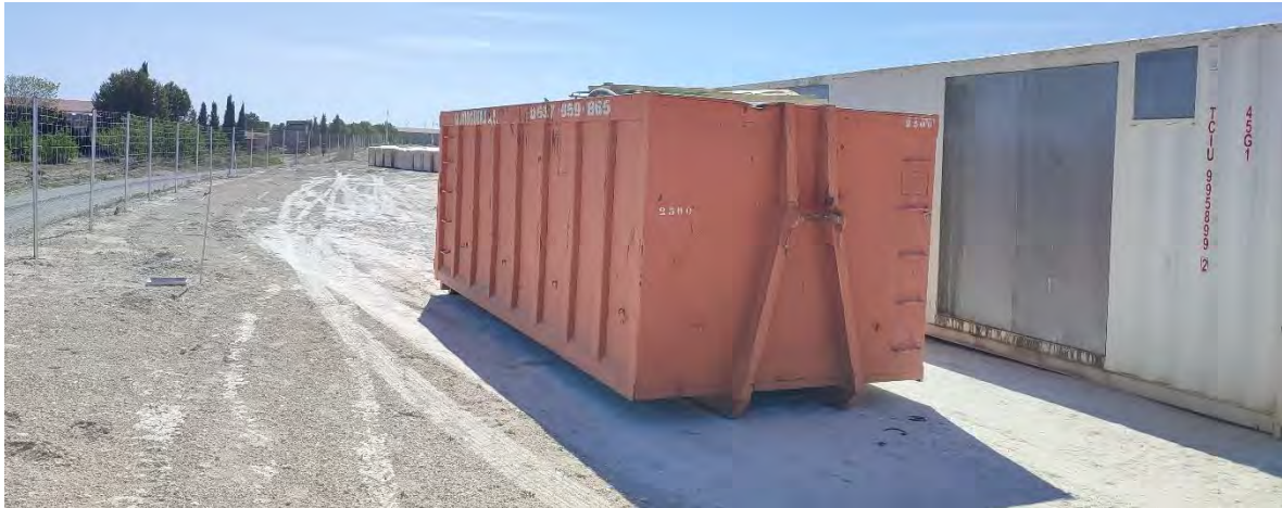
Ilustración 9. Contenedor para la clasificación de los residuos generados en la obra.
